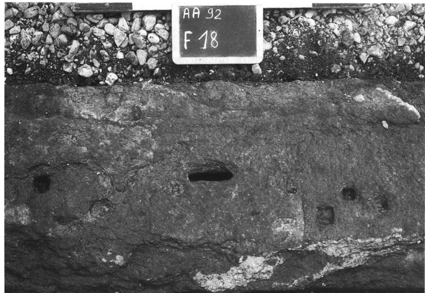
Fig. 40 Avenches/Amphithéâtre. Dalle de fondation F18 du couloir Sud. Au centre, trou de louve; de part et d'autre, trous de goujons remontant au premier usage du bloc comme seuil de porte.
