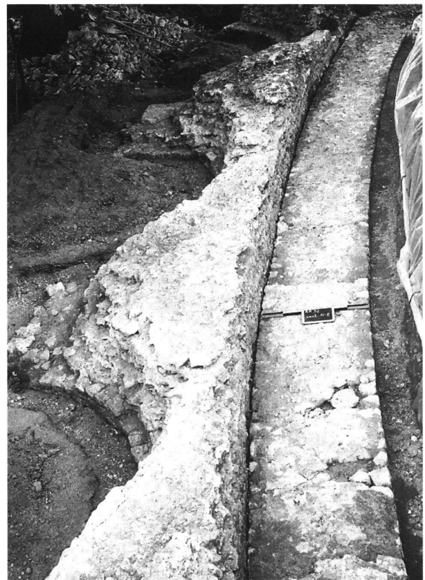
Fig. 39. Avenches/Amphithéâtre. le mur périmétrique d'origine et les alvéoles du mur postérieur dans le secteur Nord-Est.
