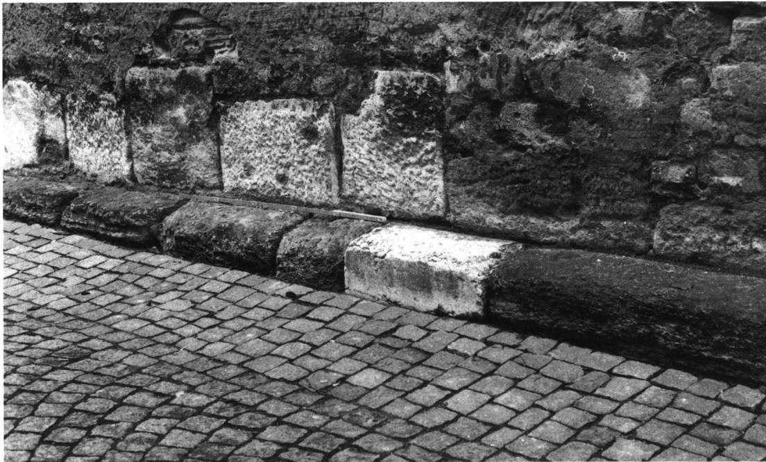
Fig. 1. Avenches, rue du Temple. Bas du mur de façade arrière (nord-est) de l'église paroissiale protestante avec bloc de calcaire urgonien blanc. Photo MRA, M. Fuchs.
