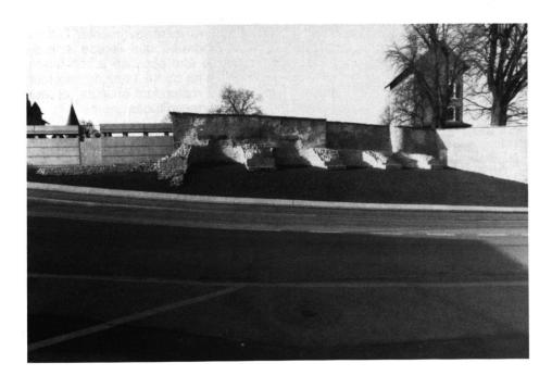
Fig. 28. Le mur périmétrique donnant sur l'avenue Jomini, avec les alvéoles du second état, le mur du premier état (à gauche) et l'élévation médiévale.
