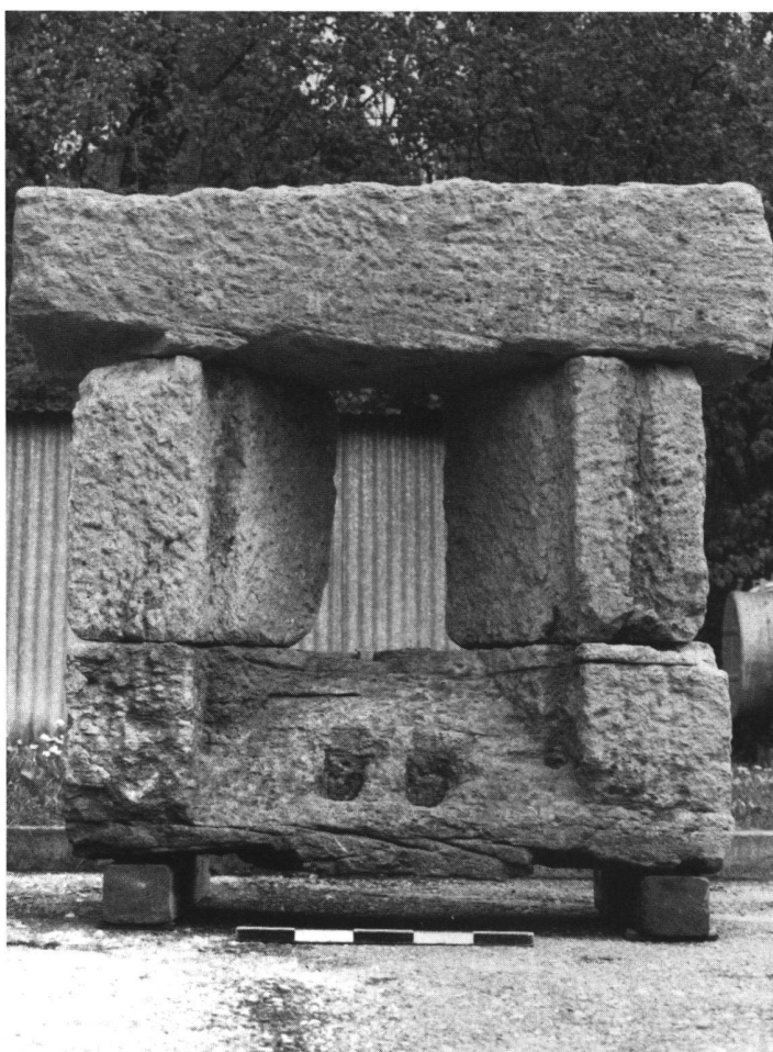
Fig. 6. Avenches / insula 7 nord. Les éléments en grès coquillier de la lucarne sud du bâtiment central remontés. Dimensions de l'ouverture extérieure : 53 x 21 cm.
