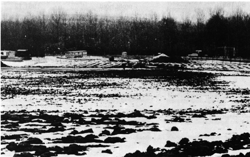
Fig. 2 Vue du canal par neige fondante, depuis son croisement avec la route Avenches-Salavaux, en direction du nord. Au deuxième plan, le canal apparaît comme une dépression, encore pleine de neige. Plus loin au nord, en revanche, il forme une longue crête dénuée de neige.
