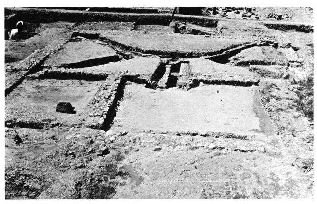
Fig. 1. Hypocauste de la quatrième étape de construction.
