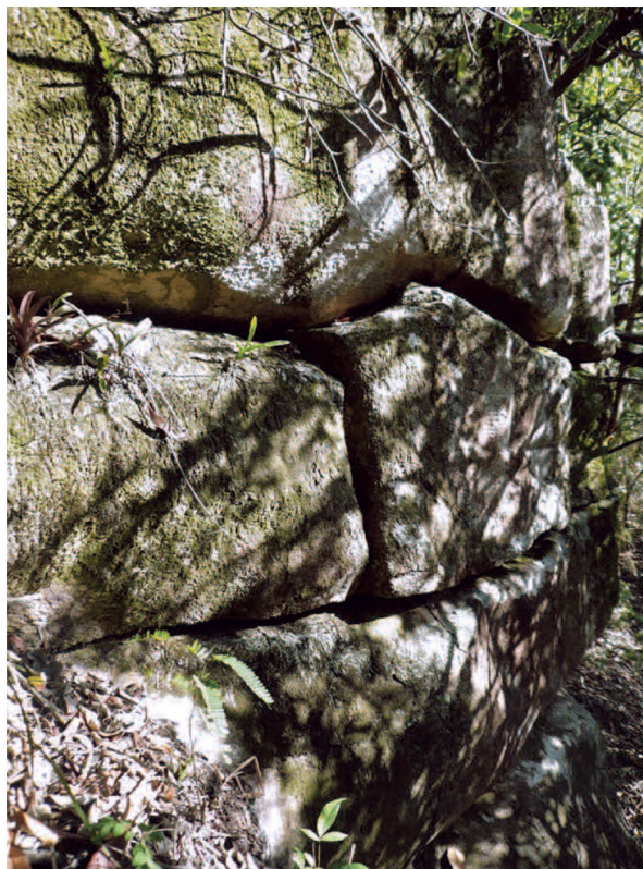
2.9. Estágio inicial de alteração observado num maciço granítico. Esta alteração está sendo imposta por intemperismo químico (alteração dos minerais), e intemperismo físico. Este último é caracterizado pelo fraturamento do maciço, segundo fraturas que fazem ângulo reto entre si.
