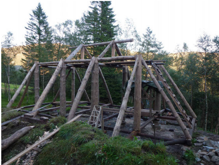
Abb. 40: Eine nordistische Baustelle (Foto: Balduin Landolt)
