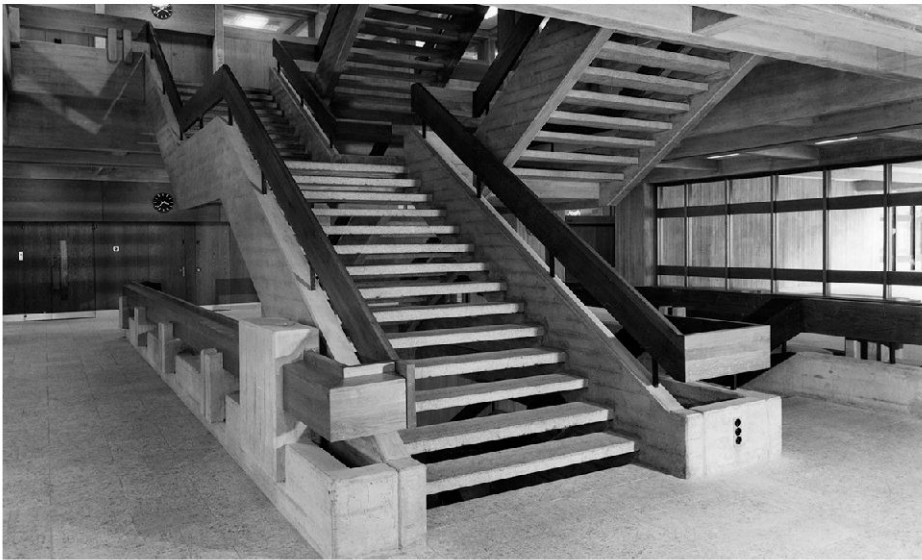
Gewerbeschule, historische Ansichten der Treppe, der Halle und eines Schulzimmers (Staatsarchiv Graubünden, Chur, Nachlass Liesch, XXI d).
