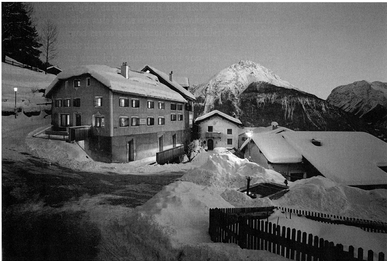
Gesamtansicht vom Dorfplatz aus.
