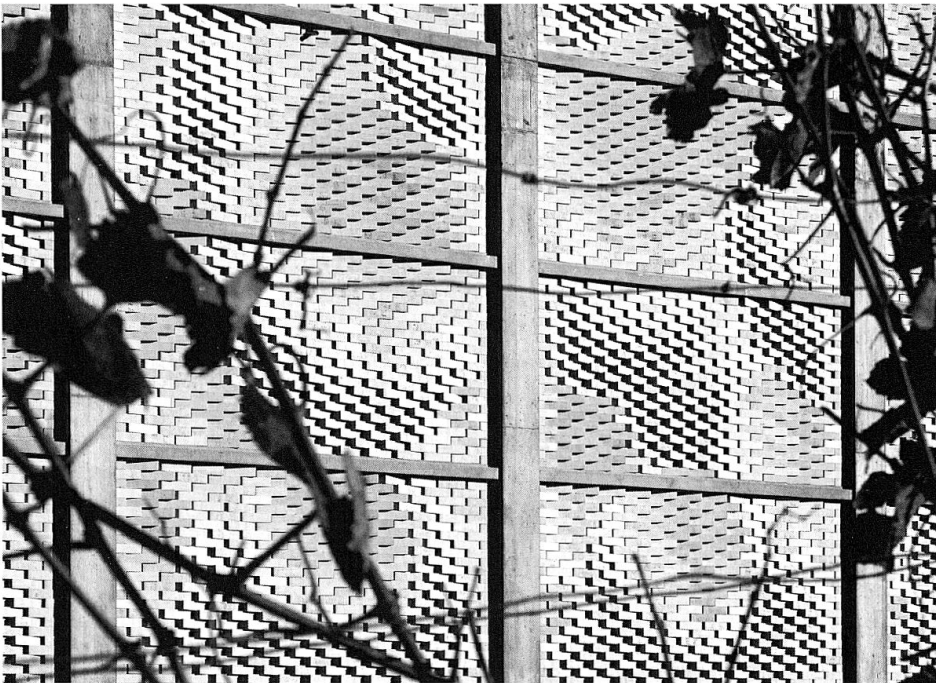
Fläsch, Weingut Gantenbein. Fassadendetail mit den mittels Roboter gemauerten Wandelementen aus Klinkersteinen (Foto: Ralph Feiner, Malans).
