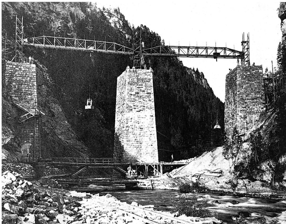
Die Pfeiler des Landwasser- viadukts im gerüstfreien Bau, Aufnahme 1901 (RhB).
