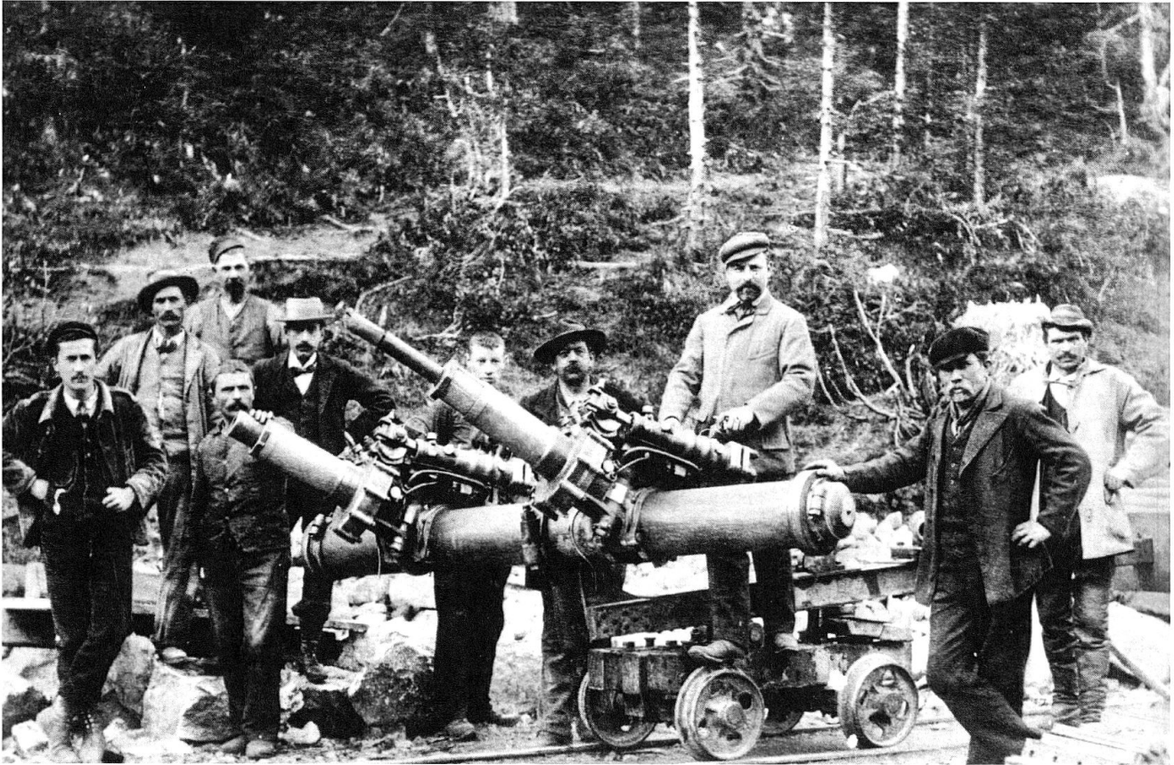
Albulatunnel. Die Bohrmannschaft mit der Brandt'schen Wasserbohrmaschine.
