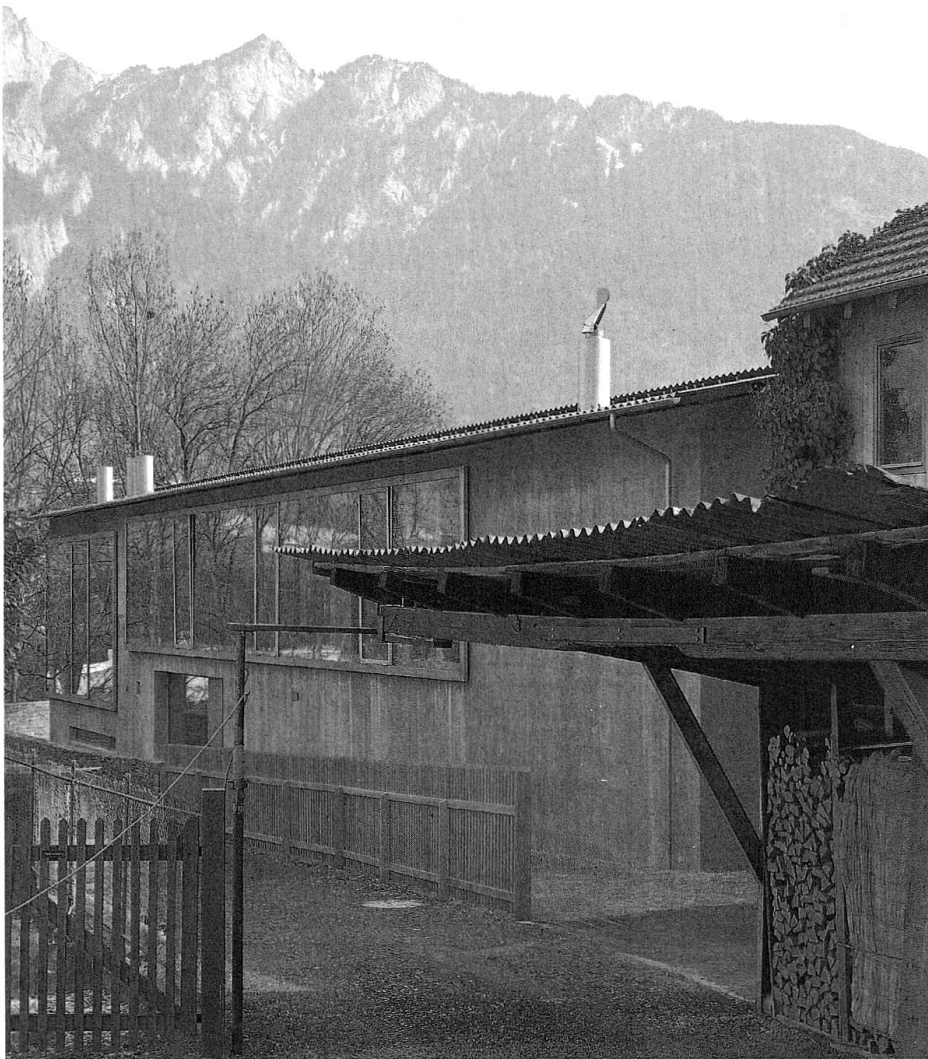
Die doppelstöckige Eingangseite des Wohntraktes.
