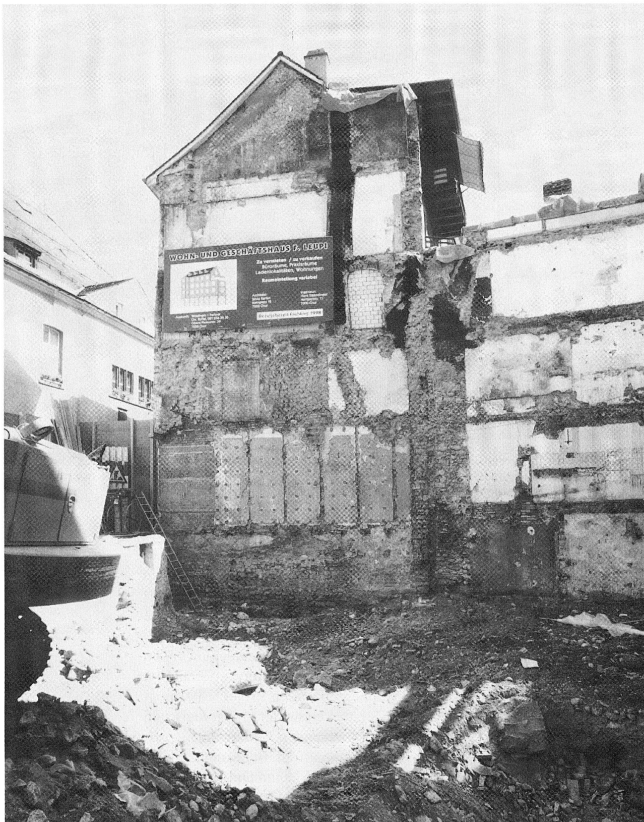
Nach dem vollständigen Abbruch des Hauses Poststrasse 30 im vergangenen Juni wurde dieser Blick an die Nordfassade des Nachbarhauses frei. Dabei konnte hochmittelalterliches Mauerwerk bis in die Höhe unterhalb der Reklametafel beobachtet werden. (Photo ADG)
