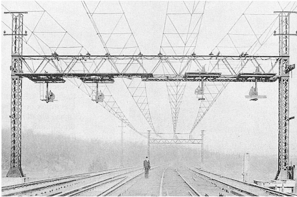
Bild 2: Starre Fahrleitung mit zwei Tragseilen (New Haven 1907).
