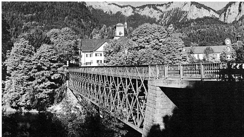
Nach dem Bau der N 13 erhielt die Brücke ein neues, bruchsteinverkleidetes Widerlager. Foto: Heini Letsch, Tamins.
