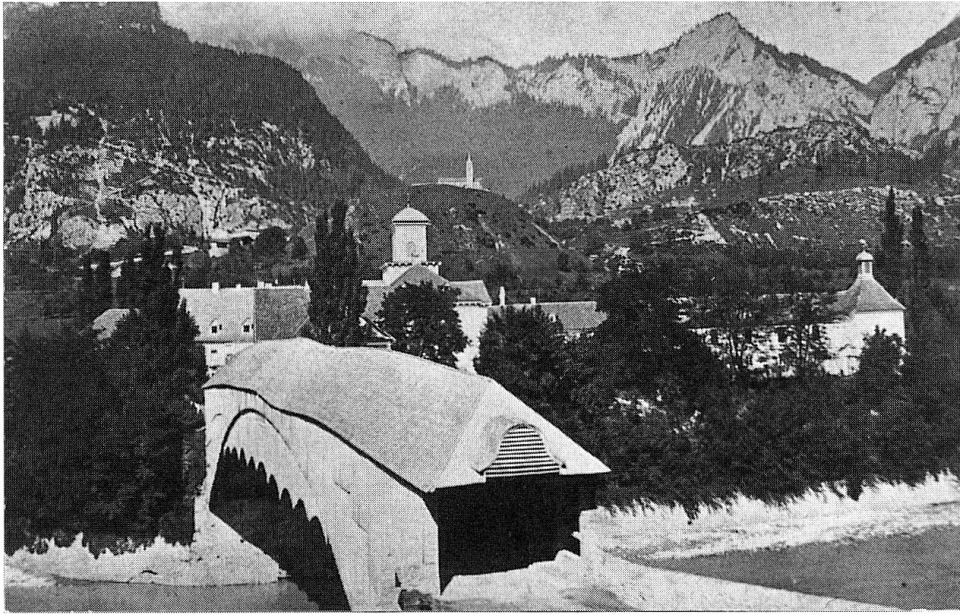
Die Stiefenhofer-Brücke mit dem deformierten Dachstuhl, der auch nach der Verstärkung der Brücke 1840 noch gut zu erkennen ist, um 1875.
