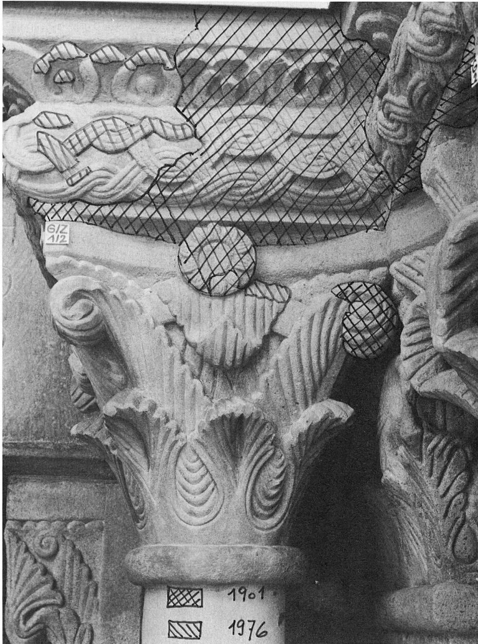
**Abb.4:** Wichtig ist das Dokumentieren der Restaurierungsarbeiten: dieses Kapitell wurde 1901 und 1976 mit Mörtel ergänzt; diese Ergänzungen sind hier schraffiert eingezeichnet. Die unschraffierten Flächen sind aus Sandstein.
