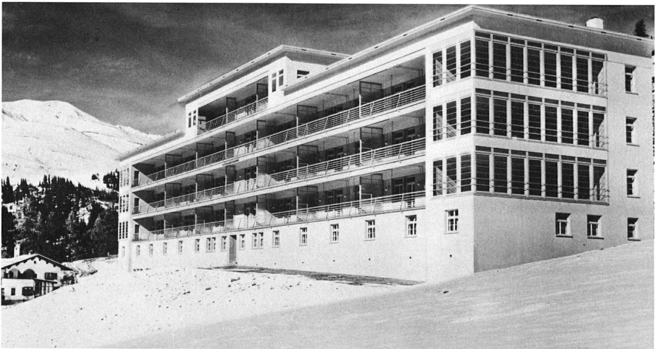
Rudolf Gaberel: Zürcher Heilstätte in Davos Clavadel, 1930–1932, Ansicht von Süden.
