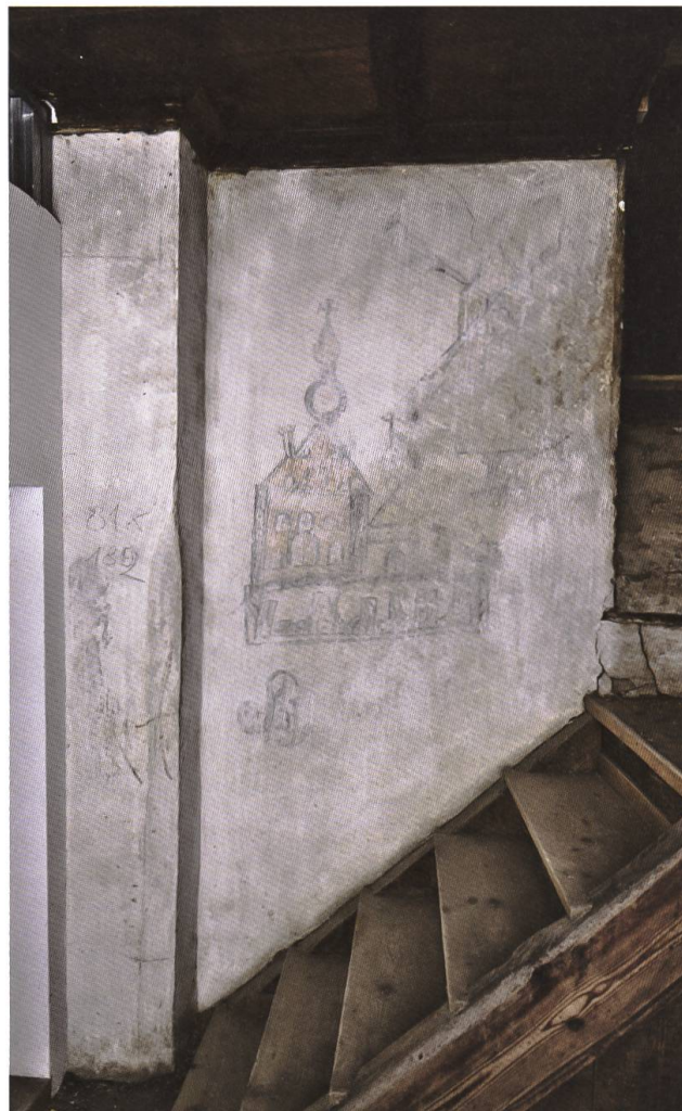
Soglio, Casa Guberto, Obergeschoss, Gang, Ostwand. Übersicht. (Foto ADG 2020)
