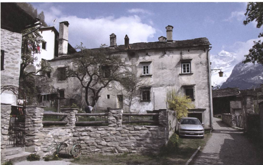
Oben: Soglio, Casa Guberto, von Süden. (Foto Denkmalpflege GR 2019)
