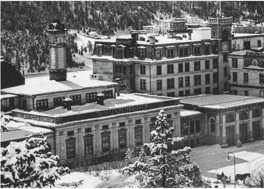
Hotel Kulm St. Moritz. (Sammlung Jochen Ziegelmann) Am Erweiterungsbaun von Nicolaus Hartmann (von 1887 und 1900) erkennt man Elemente wie den wuchtigen Schornstein, das Palladiofenster (im Turm) sowie Arkaden, welche sich auch in der Fassadengestaltung des Waldhaus Vulpera wiederfinden.
