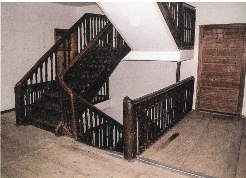
Die Erschliessungshalle im zweiten Obergeschoss. Bemerkenswert ist neben der eichenen Wangentreppe mit den schlanken, zeittypisch flachen Balustern auch der massive Bretterboden.
