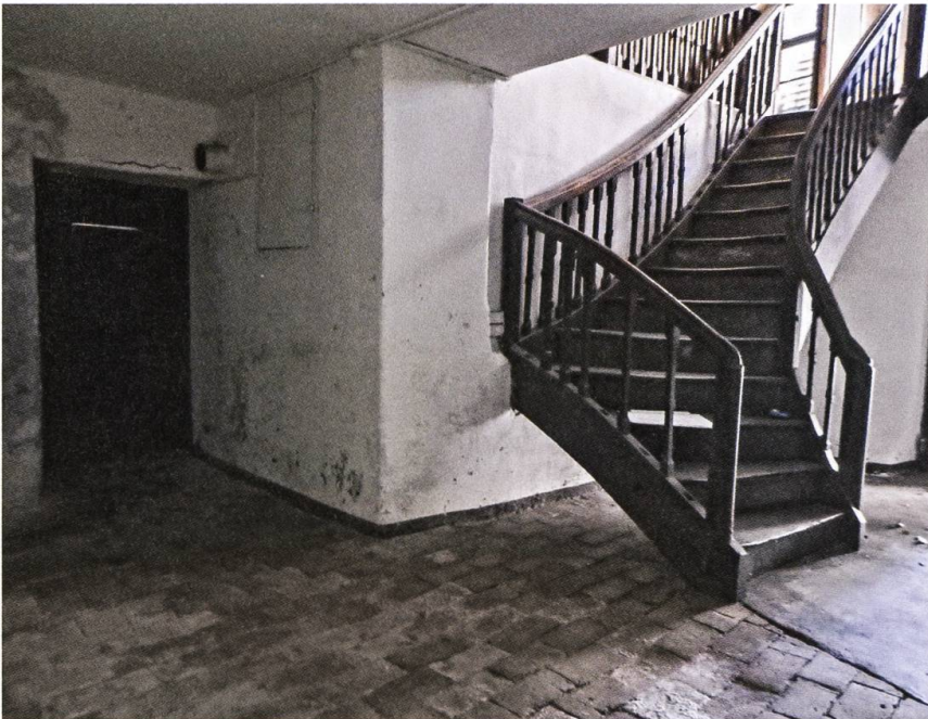
Das Vestibül mit dem frei hineingestellten Treppenaufgang. Die gewundene Holzterre führt in einheitlicher Gestaltung durch die zentralen Hallen vom Erdgeschoss bis in den Estrich.
