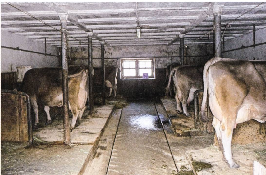
Der um 1910 neu eingerichtete Stall mit gusseisernen Säulen und Hourdisdecke aus Stahlträgern.
