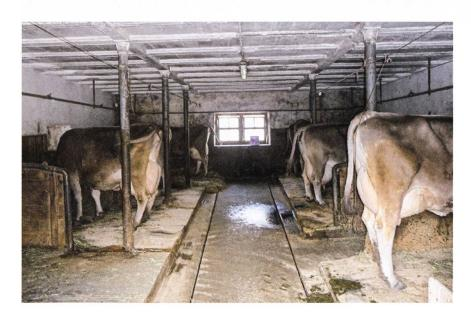
Der um 1910 neu eingerichtete Stall mit gusseisernen Säulen und Hourdisdecke aus Stahlträgern.
