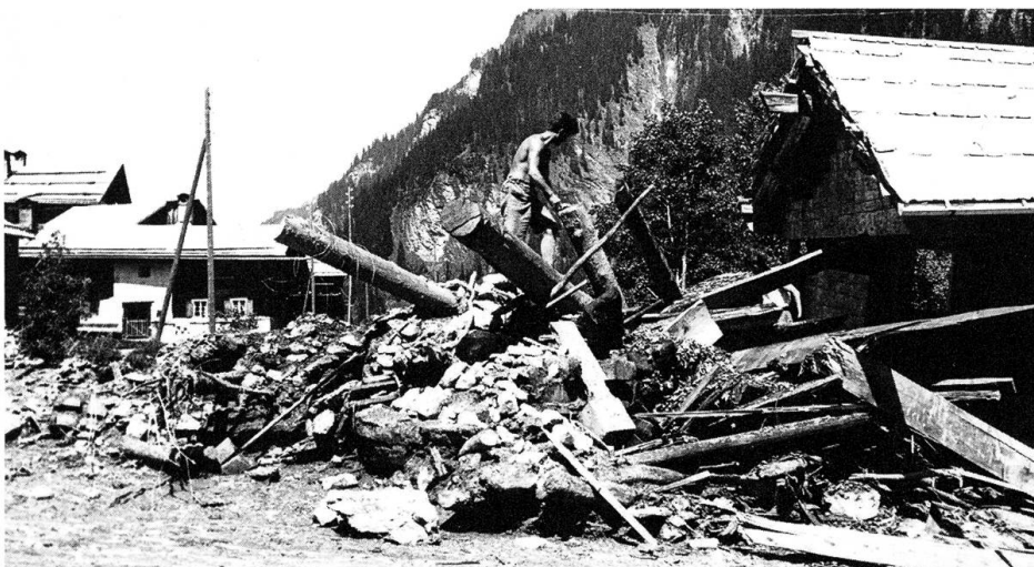
Die Platzertobelröfe von 1932 richtete auf dem untern Platz grosse Schäden an. (Sammlung W. Buchli, Chur)
