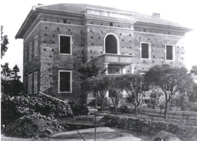
Abb. 47, 48: Eingangsfront des Hauses Caflisch in Catania kurz nach dem Abbau des in Löchern an der Hausmauer verankerten Gerüsts (links), Gartenfront nach der Fertigstellung (rechts).
