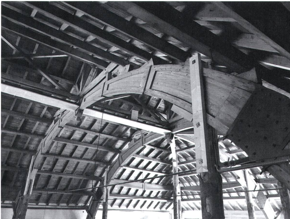
Abb. 13: Anbringung der Zugstange von 1917 über den originalen Befestigungsplatten der Hetzerbinder. (F. Gramegna, 2018)
