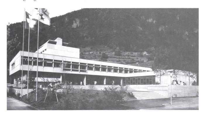
Hohe Qualität der Materialien und Langlebigkeit der Bauten waren Liesch ein grosses Anliegen. So wies er darauf hin, dass die gewählte Fassadenkonstruktion der «relativ kurzen, beweglich gelagerten Fassadenelemente» sich für das raue Bergklima besonders eignen würde, da «bei hohen Temperaturunterschieden nur unwesentliche Spannungen (entstehen würden), was die Rissgefahr erheblich vermindert.»
