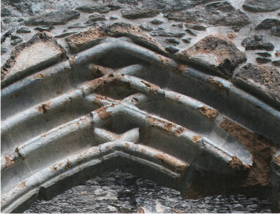
Abb. 12: Die behauenen Tuffsteine sind heute noch mit hellgrauer Farbe geschlämmt.
