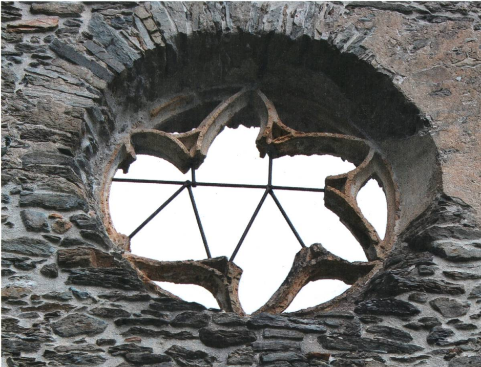
Abb. 13: Zustand der 1924 gesicherten Rosette.
