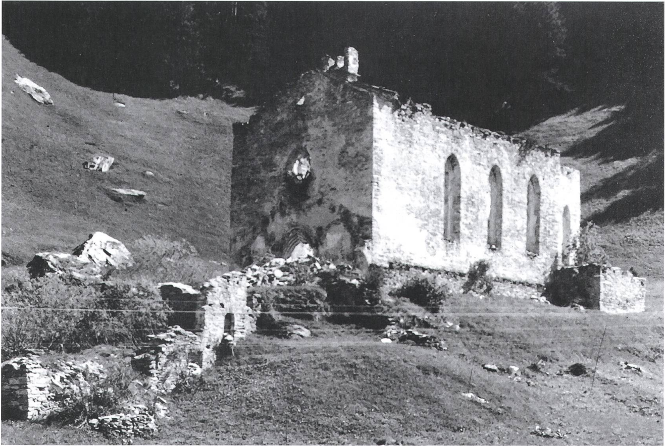
Abb.5: Zustand der Kirche und des Hospizes (links) vor 1925. StAGR, Meisser 03217.
