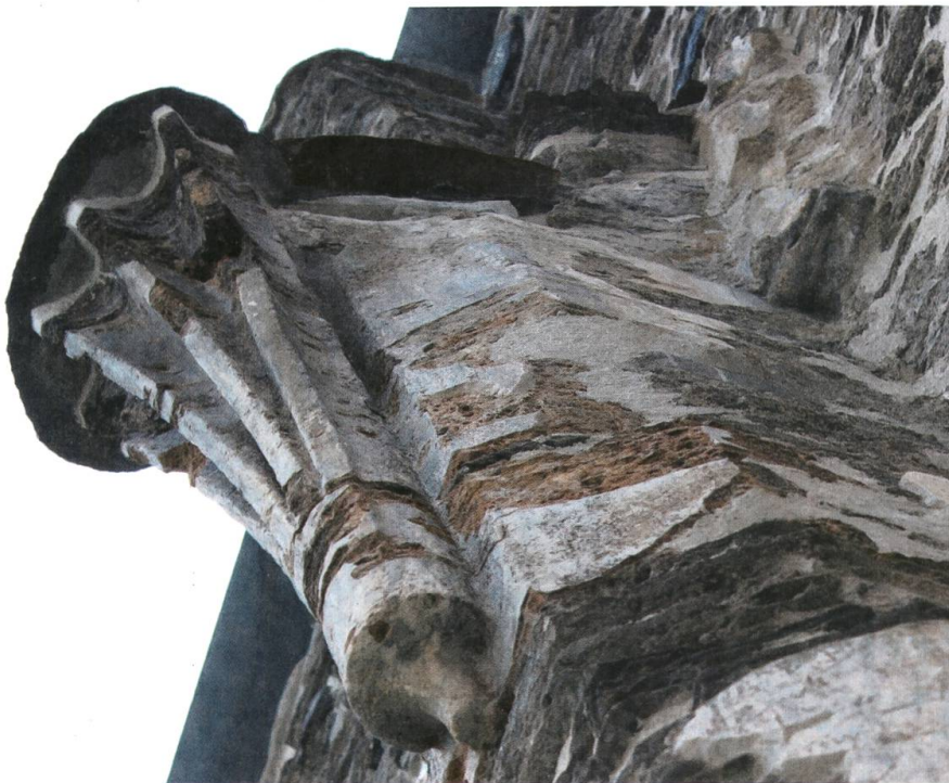
Abb. 15: Gewölbeansatz mit dem Schutzdach. Zustand der 1924 gesicherten Rosette.
