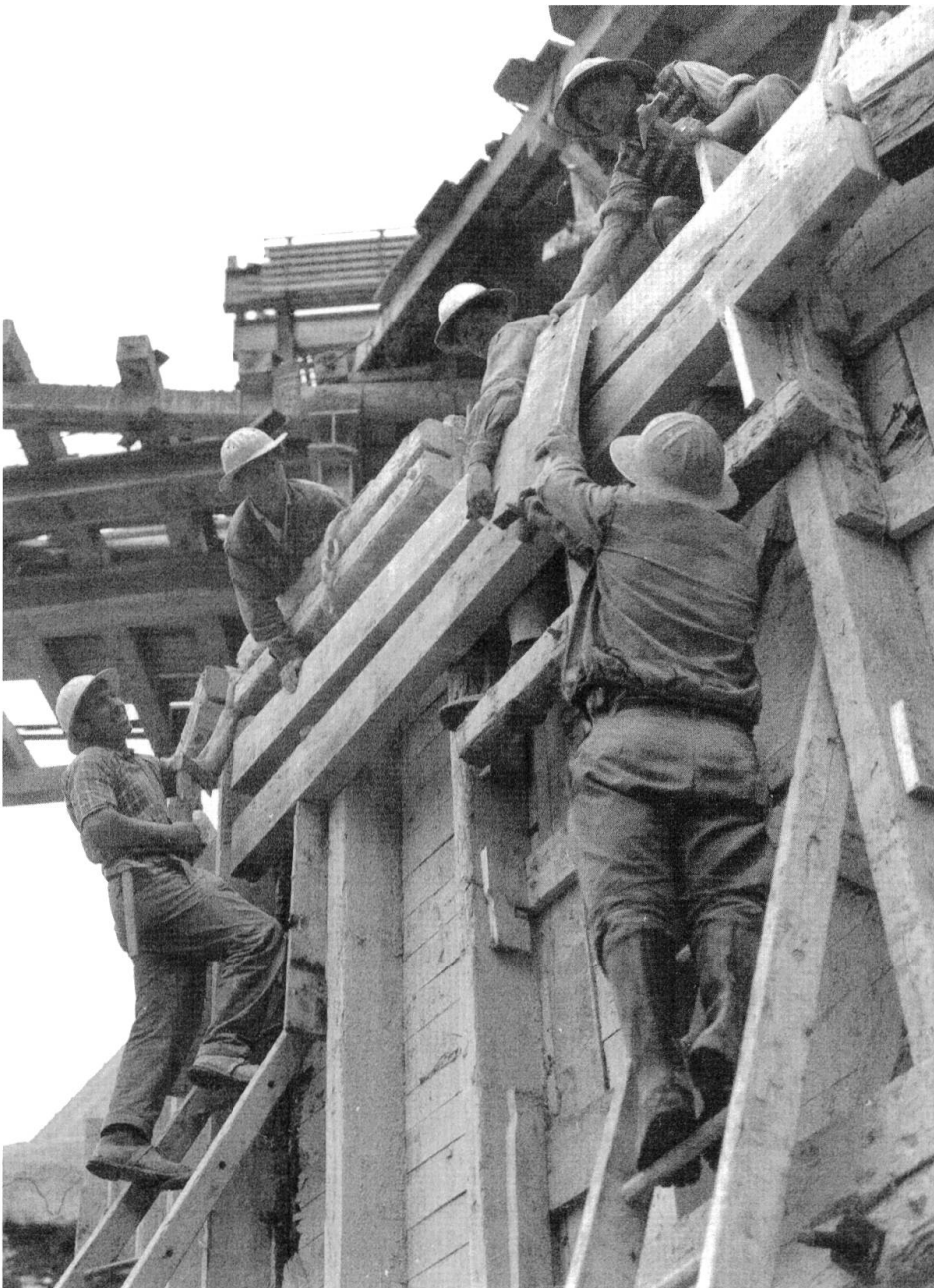
Abb. 48: Arbeiter beim Bau der Staumauer auf Albigna.
