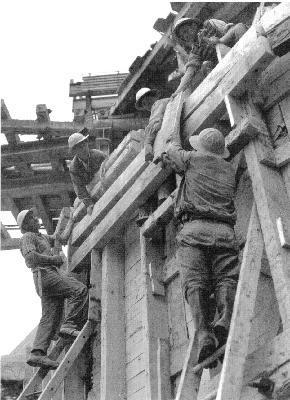
Abb. 48: Arbeiter beim Bau der Staumauer auf Albigna.
