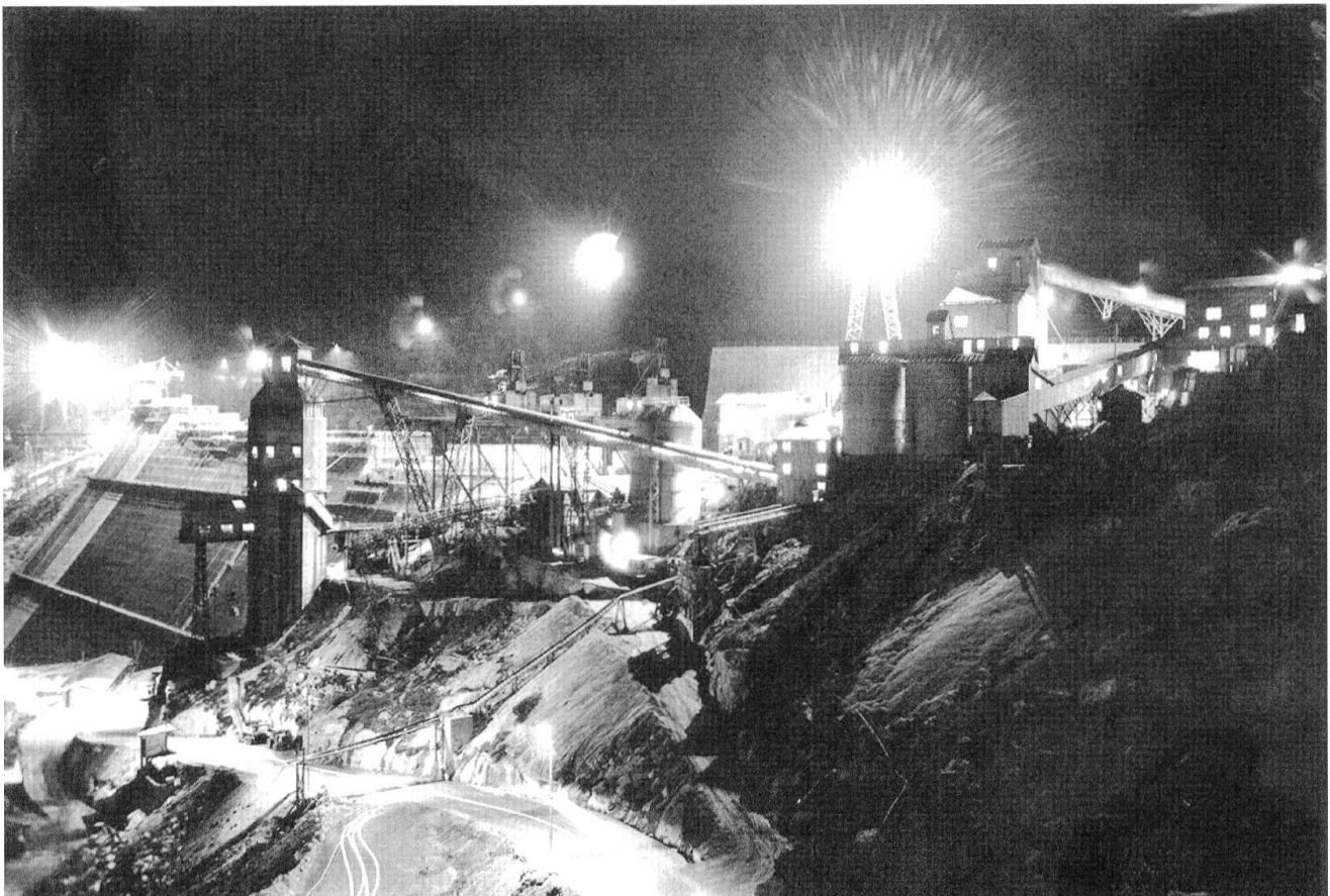
Abb. 45: Baustelle Albigna bei Nacht.
