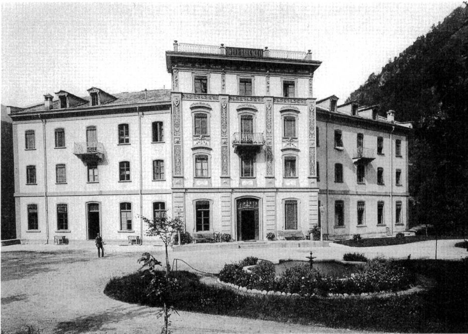
Abb. 02: Hotel Bregaglia in Promontogno von Nordosten. Das für Theodor Scartazzini nach Plänen von Giovanni Sottovia erbaute Hotel eröffnete 1877.
