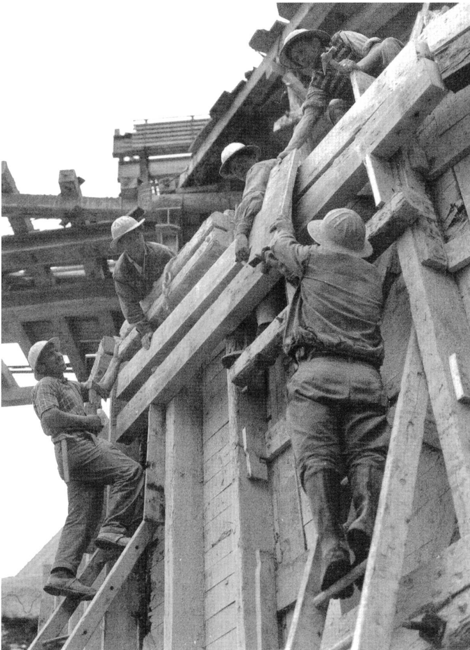
Abb. 48: Arbeiter beim Bau der Staumauer auf Albigna.
