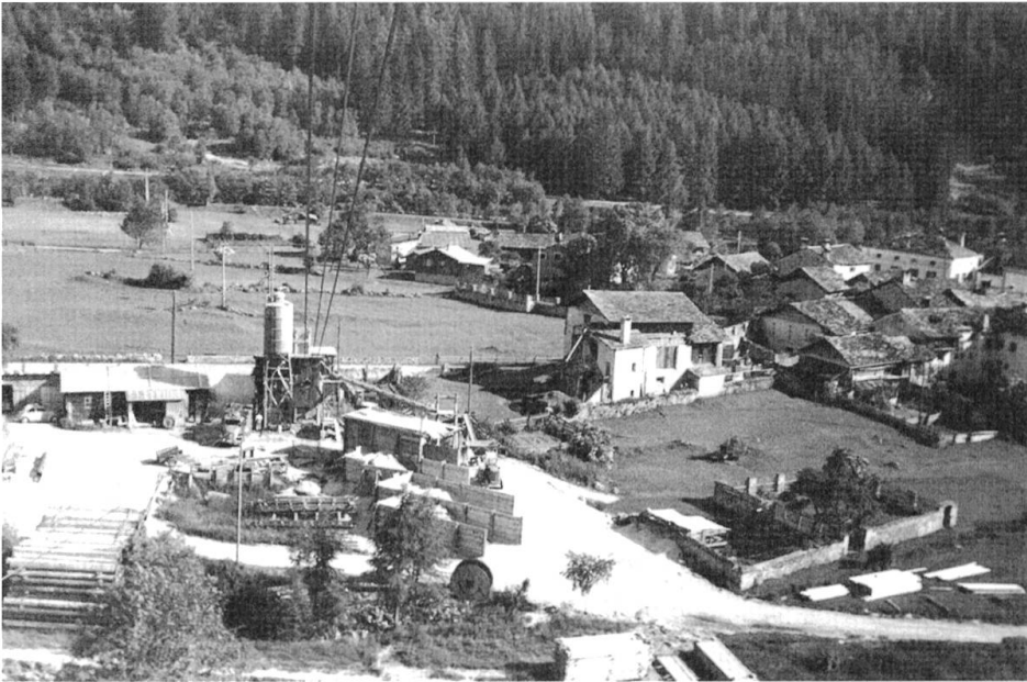
Abb. 38: Talstation Vicosoprano für die Seilbahn, die zum ca. 350 m über dem Dorf liegenden Druckstollenfenster führte.
