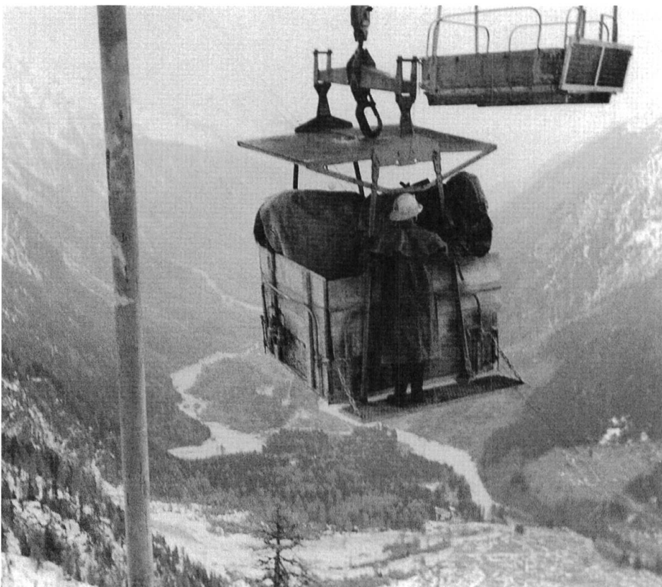
Abb. 37: Transport eines Maultiers auf Murtaira für den Arbeitseinsatz am Druckstollen Forno-Piancanin.
