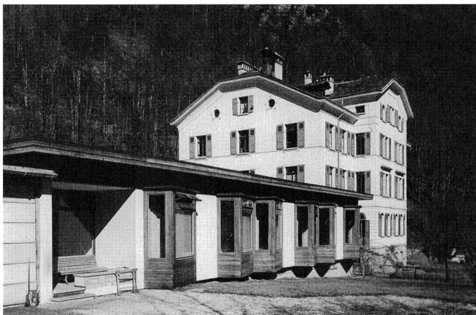
Abb. 47: Kreisspital «Flin» bei Spino mit dem von Architekt Bruno Giacometti errichteten Anbau.
