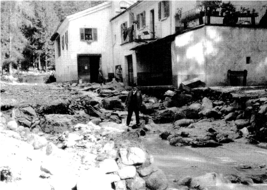
Abb. 21: Hochwasserschäden beim Crotto oberhalb Vicosoprano, 1927.
