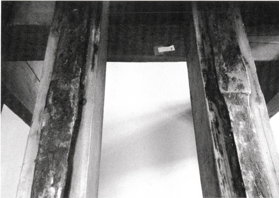
Abb. 4: Die angelängten Schienen, auf denen der Karren hinein- und herausgekurbelt wurde, sind (im Vergleich mit andern Pressen) sehr wenig abgenutzt. Ihre raue Oberfläche liess zudem den Bleisatz beim Hin- und Herfahren des Karrens erzittern, was leicht zu hochsteigenden Buchstabenabständen (sog. Spiessen) führen konnte, die dann plötzlich wie senkrechte Striche druckten.
