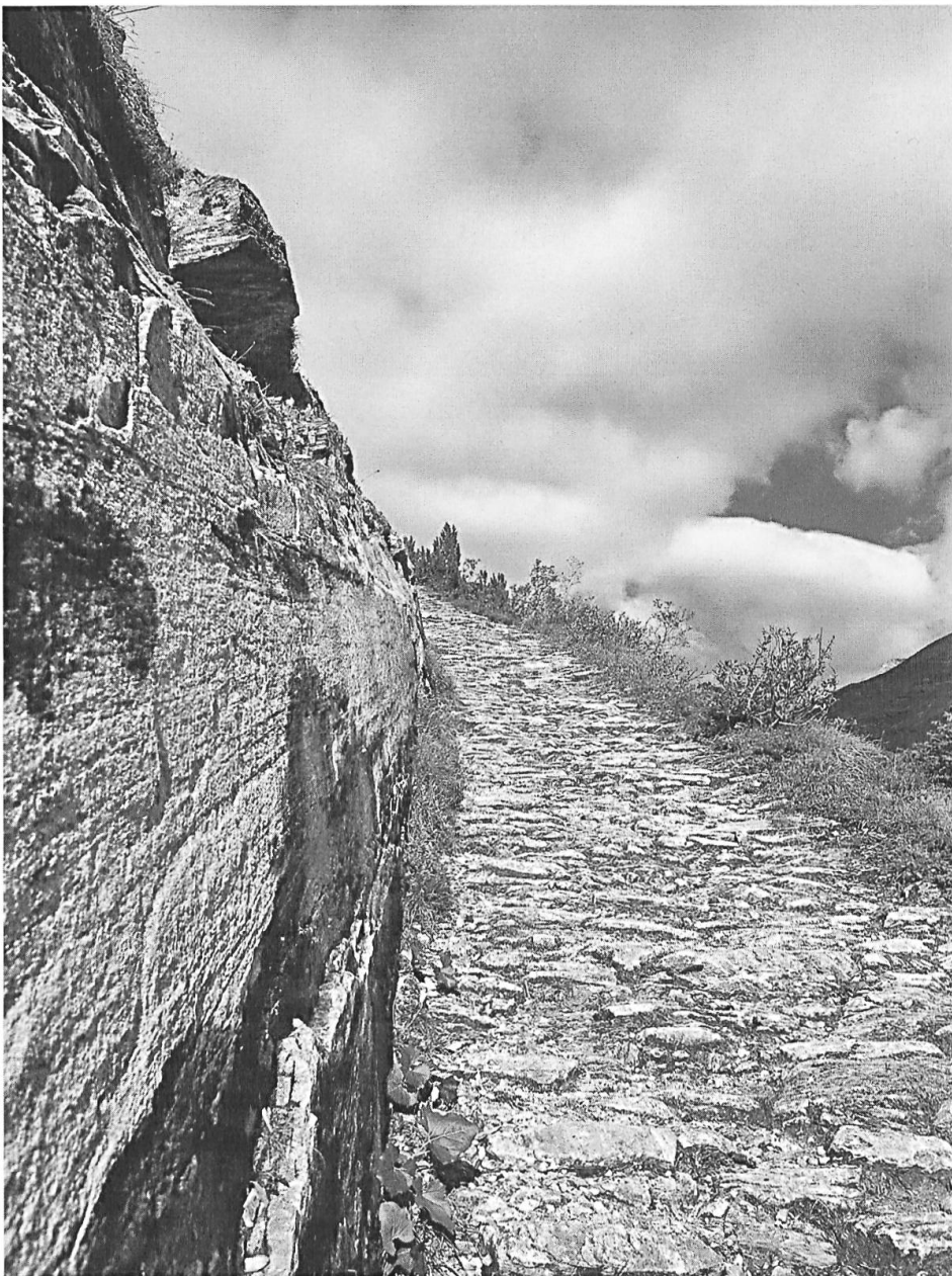
Flimserstein: Eine in den Felsen geschrotete Wegenlage aus dem 17. Jahrhundert mit talseitiger Trockenmauer (Foto: ViaStoria/Heinz Dieter Finck).
