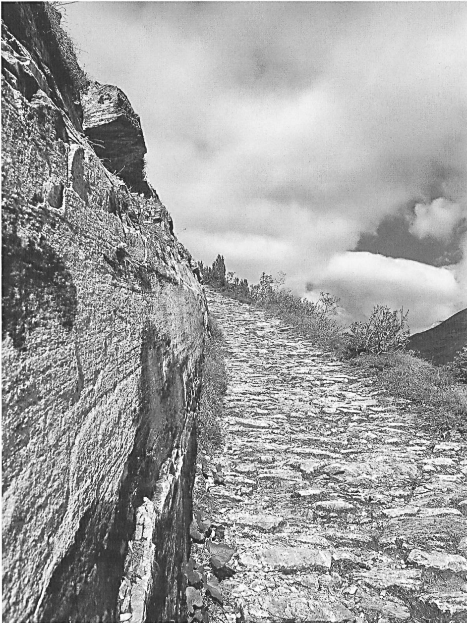
Flimserstein: Eine in den Felsen geschrotete Weganlage aus dem 17. Jahrhundert mit talseitiger Trockenmauer (Foto: ViaStoria/Heinz Dieter Finck).
