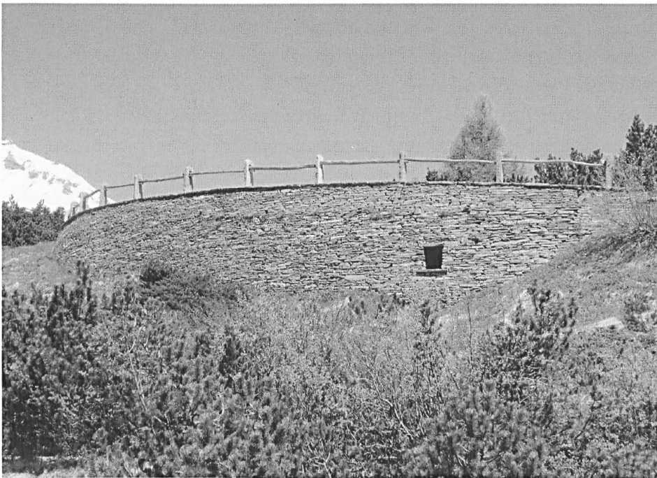
Bei der Sanierung der Bernhardin-Strasse wurde beispielhaft versucht, die sicherheitstechnischen und denkmalpflegerischen Ziele miteinander zu verbinden, um das charakteristische Erscheinungsbild der ehemaligen Kommerzialstrasse beizubehalten (Foto: Paolo Mantovani).
