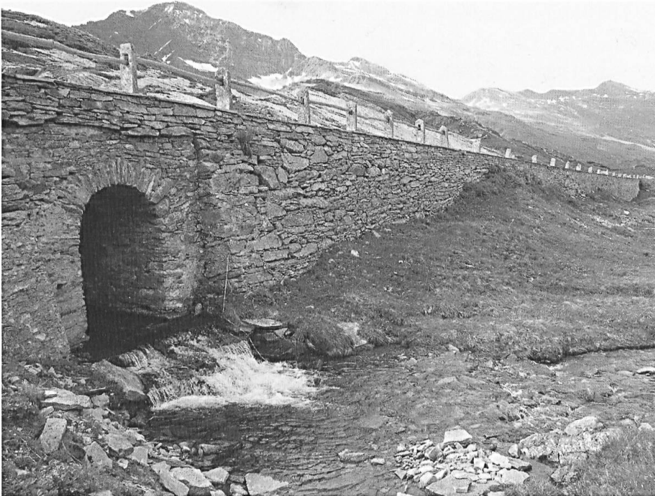
Ein vorbildlich saniertes Teilstück der Bernhardin-Strasse: Die Stützmauern, Wegbegrenzungssteine und der Wasserdurchlass (Tombino) konnten in ihrer traditionellen, für die Kommerzialstrassen charakteristischen Bauweise erhalten werden (Foto: Marco Marcacci).
