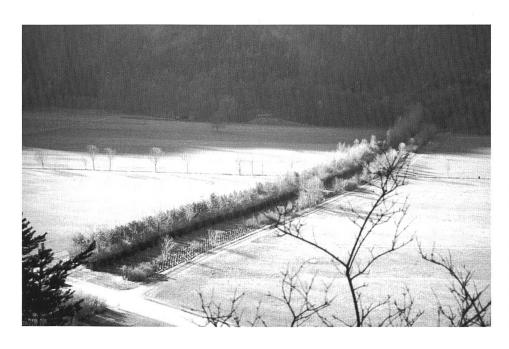
Blick vom Artilleriewerk Ansstein auf das Geländepanzerhindernis Ansstein (T 03326). In der vorderen Reihe das 1939 errichtete Infanteriehindernis aus einbetonierten Schienen. Dahinter, vom Gebüsch überwuchert, die Reihe der Betonhöcker von 1941 (Foto: ADAB-Inventar 1999).
