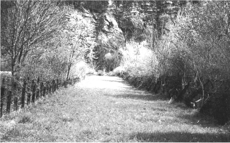
GPH Ansstein (T 03326) mit Infanteriehindernis (links) und Betonhöckerreihe (rechts) (Foto: ADAB-Inventar 1999).
