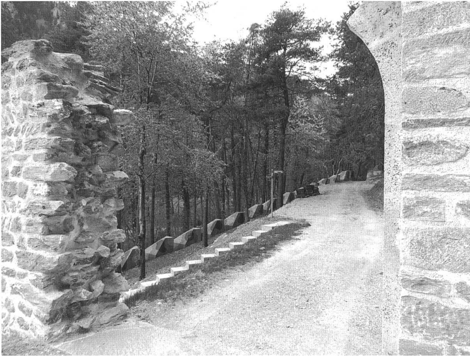
Blick durch das Tor der Unterburg Hochjuvalt (Porta Raetica) auf die an das mittelalterliche Gemäuer anschliessende Betonblockreihe. Die Betonblöcke wurden vor einigen Jahren neu mit Tarnbemalung versehen (Foto: Thomas Bitterli-Waldvogel).
