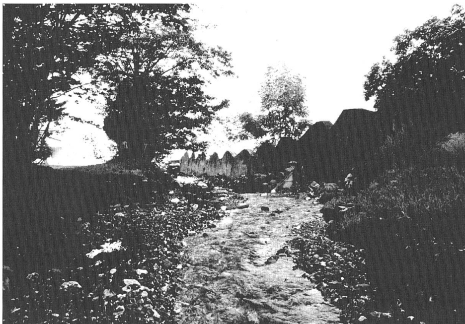
Getreppte Sperrmauer des GPH Trimmis (T 03350) entlang dem Rüfibach (Foto: ADAB-Inventar 1999).
