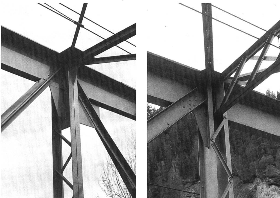
Knotendetails der Farsch- und der Isla-Bella-Brücke im Vergleich. Bei gleicher statischer Funktion sind die Bauteile von den jeweiligen Konstruktionswerkstätten unterschiedlich ausgebildet worden. Die Stegbleche unterhalb der Obergurte sind als Verstärkungsmassnahme 1960 durch die Firma Josef Meyer Eisen- und Waggonbau aus Rheinfelden angeschweisst worden.
