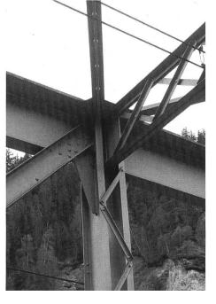
Knotendetails der Farsch- und der Isla-Bella-Brücke im Vergleich. Bei gleicher statischer Funktion sind die Bauteile von den jeweiligen Konstruktionswerkstätten unterschiedlich ausgebildet worden. Die Stegbleche unterhalb der Obergurte sind als Verstärkungsmassnahme 1960 durch die Firma Josef Meyer Eisen- und Waggonbau aus Rheinfelden angeschweisst worden.
