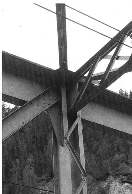
Knotendetails der Farsch- und der Isla-Bella-Brücke im Vergleich. Bei gleicher statischer Funktion sind die Bauteile von den jeweiligen Konstruktionswerkstätten unterschiedlich ausgebildet worden. Die Stegbleche unterhalb der Obergurte sind als Verstärkungsmassnahme 1960 durch die Firma Josef Meyer Eisen- und Waggonbau aus Rheinfelden angeschweisst worden.
