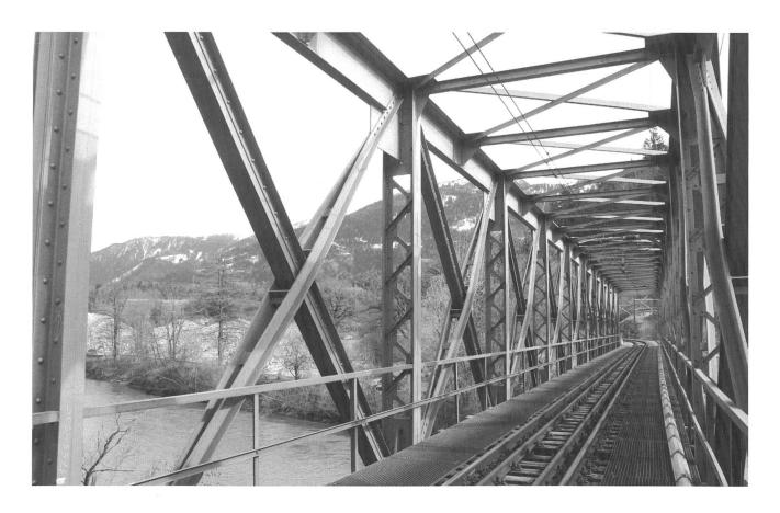
nieure an, dass die bestehende Konstruktion «nicht rationell» verstärkt werden könne. Der Ersatzbau des Ingenieurs Ulrich Schlumpf ist eine originelle Stahl-Beton-Verbundkonstruktion mit fester Fahrbahn; sie wurde 2017 vom Churer Ingenieurbüro Casutt Wyrsch Zwicky instandgesetzt.
