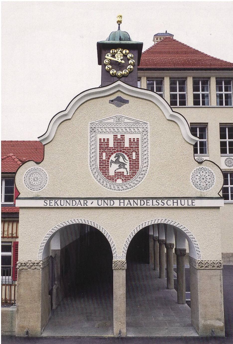
Haupteingang Quaderschulhaus mit Wappen-Sgraffito, Chur 1914 (Foto: Martin Fuhrer).
