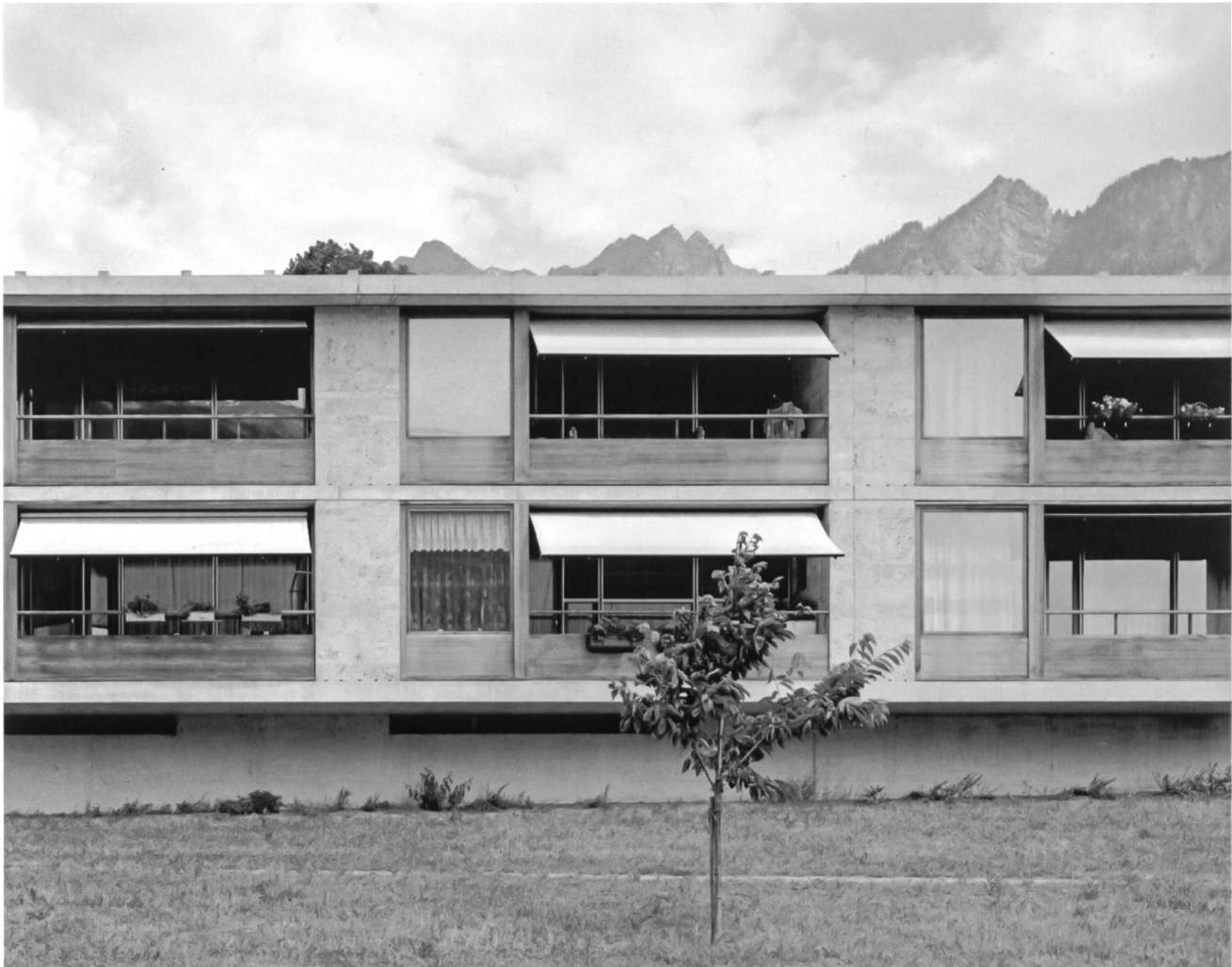
Westfassade (© Hélène Binet).
