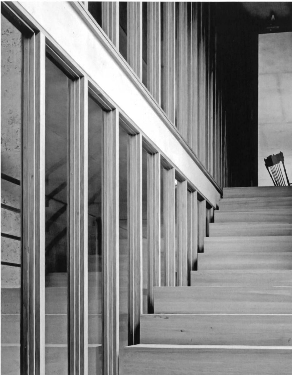
Verglasung der Treppe (© Hélène Binet).
