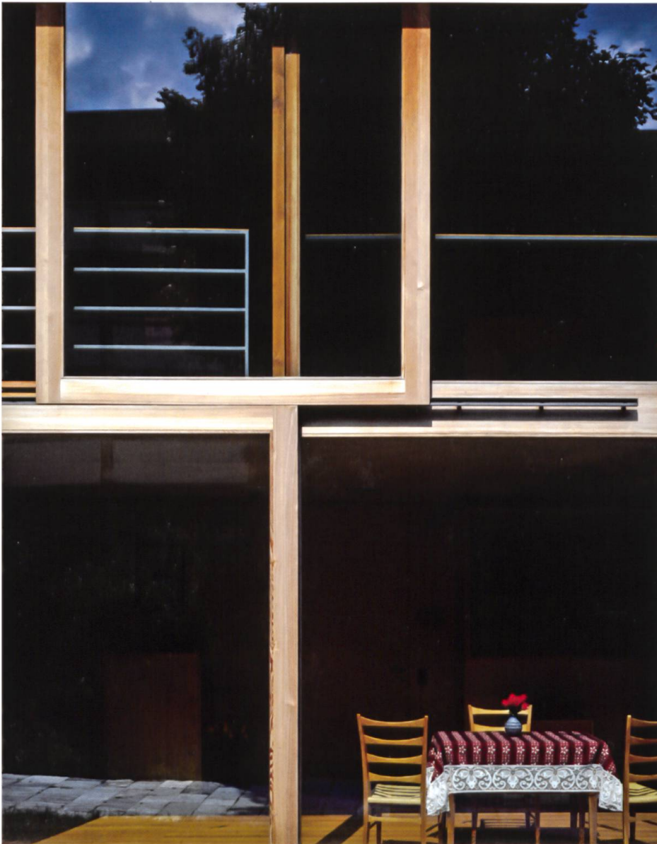
Mit den Schiebefenstern lässt sich die Laubenhalle grosszügig öffnen (© Hélène Binet).
