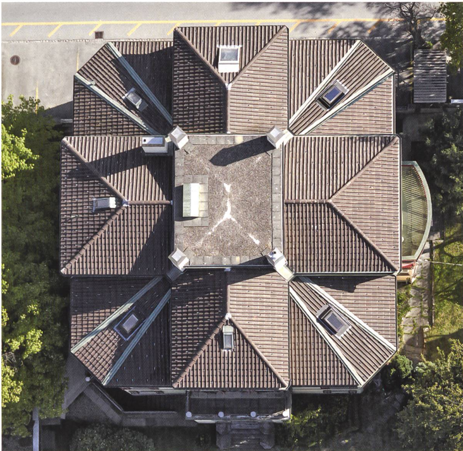
Flugansicht mit Flachdach, vier Mittelrisaliten und vier Eckstücken.
