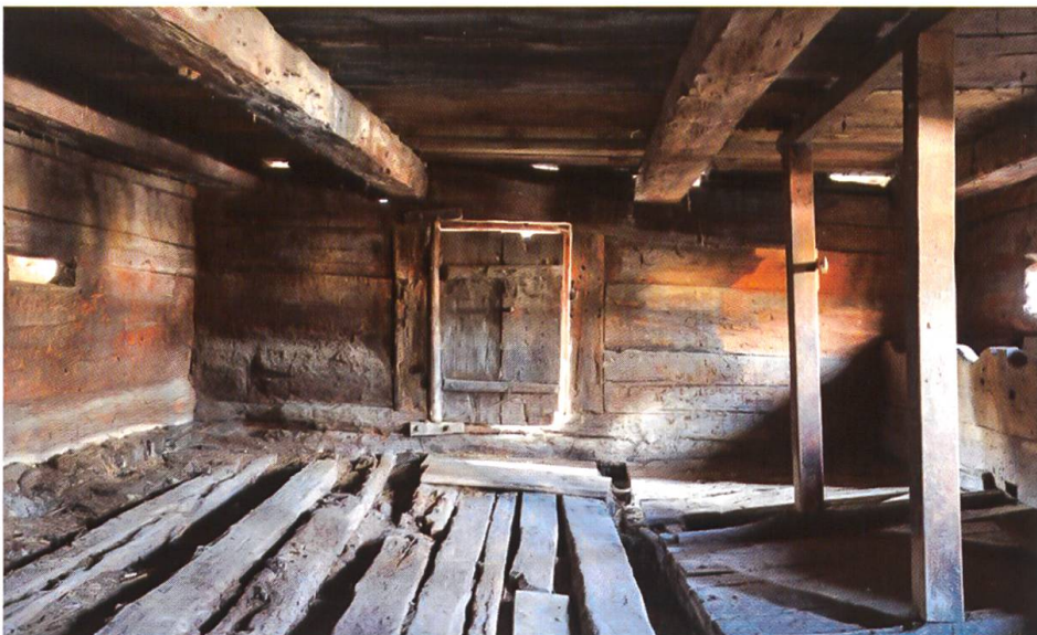
Läger, Futterkrippe und Mittelgang im Stall bestehen aus Bohlenbrettern (Foto: Philipp Imboden, Chur).
