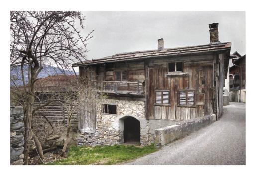
Annäherung ans Jooshuus: Bereits von der Gasse aus wird der älteste Hausteil sichtbar – der mit Brettern verschalte, zweistöckige Holzstrickteil von 1452 (Foto: Ralph Feiner, Malans).
