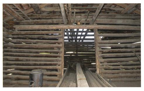
Blick in die Scheune über dem Stall: Der in offener Blockbauweise erstellte – und somit gut belüftete – Scheunenraum ist vom Hof aus links über eine Holzrampe erschlossen.
