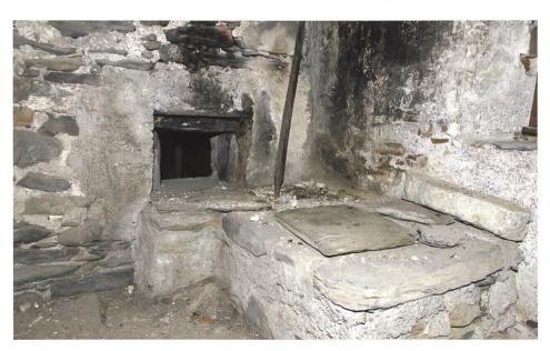
Kochen und Einheizen an der dritten Feuerstelle im zweiten Obergeschoss: Die Feuerstelle wärmte einst den grossen Ofen im talseitig anschliessenden Raum.
