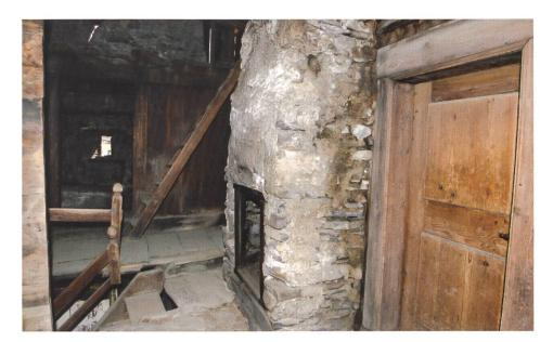
Heizen nach einem einfachen Prinzip: Die Wärme der Feuerstelle – im Bild die Feuerstelle hausmittig im zweiten Obergeschoss – sorgt für Wärme in der guten Stube dahinter.
