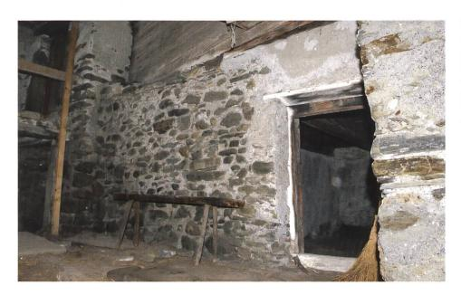
Blick vom Hof aus nach rechts: Unten ersichtlich ist der Zugang zu einem der Keller unter dem Hausteil von 1452. Über dem Eingang zeigt sich die geschlossene Holzstrickwand der spätmittelalterlichen Wohnstube.
