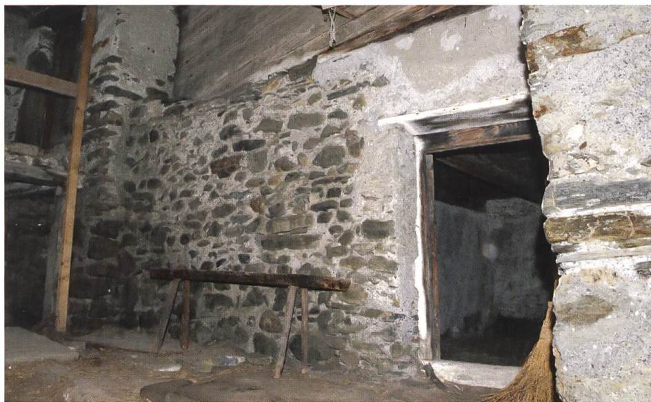
Blick vom Hof aus nach rechts: Unten ersichtlich ist der Zugang zu einem der Keller unter dem Hausteil von 1452. Über dem Eingang zeigt sich die geschlossene Holzstrickwand der spätmittelalterlichen Wohnstube.
