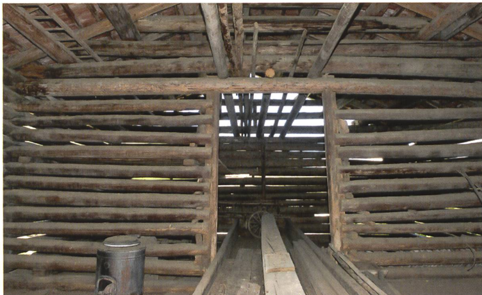
Blick in die Scheune über dem Stall: Der in offener Blockbauweise erstellte – und somit gut belüftete – Scheunenraum ist vom Hof aus links über eine Holzrampe erschlossen.
