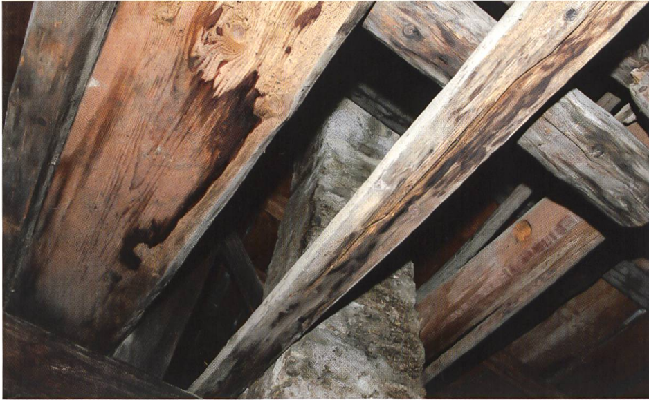
Der zentral durchs Haus führende Kaminzug auf Höhe Dachgeschoss: Dies ist nicht der grösste Kaminzug im Jooshuus, aber wohl derjenige, der noch am längstem Russ und Rauch unter das Dach statt über dieses hinaus brachte.
