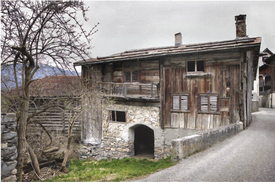
Annäherung ans Jooshuus: Bereits von der Gasse aus wird der älteste Hausteil sichtbar – der mit Brettern verschaltete, zweistöckige Holzstrickteil von 1452 (Foto: Ralph Feiner, Malans).
