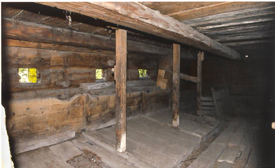
Im Stall von 1572: Das Grossvieh wurde paarweise vor Futterkrippen entlang der Längswände untergebracht. Belüftet wird der Stall talseitig durch kleine, nachträglich ausgestemmte Öffnungen in der sonst geschlossenen Holzstrickwand.
