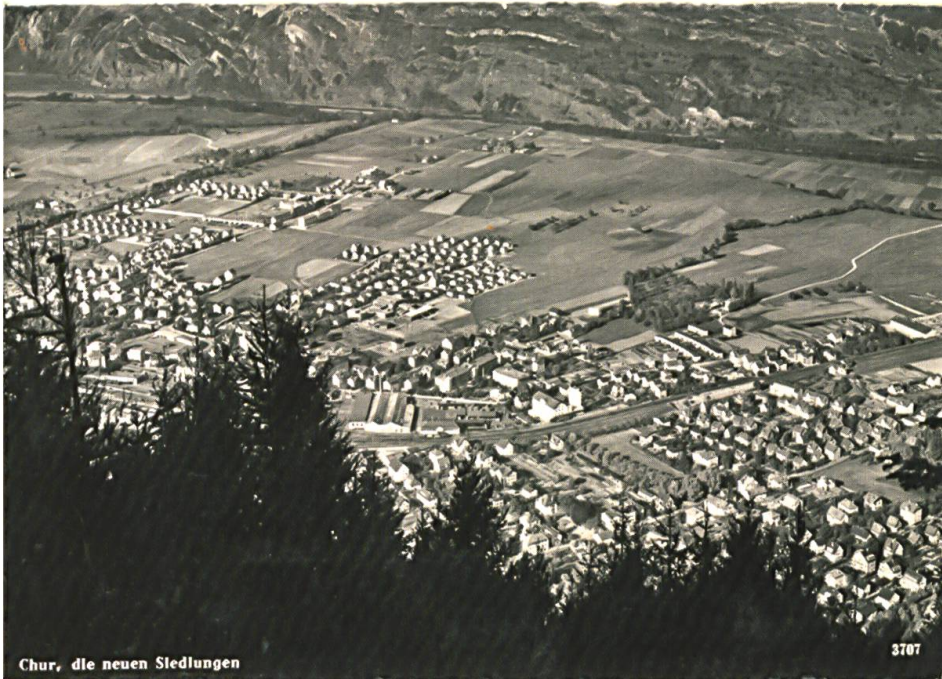
Ansichtskarte «Chur, die neuen Siedlungen», 1947. In der Rheinebene wurden in den 1940er-Jahren einige Plansiedlungen mit Einfamilienhäusern errichtet. Mit der zeitgleich entstandenen Wohnkolonie «Waldhaus» haben sie die kleinbürgerliche Ästhetik des «Ländli-Heimatstils» gemein (Sammlung Max Dendorfer, in: Historischer Städteatlas der Schweiz . Chur. Chur 2011, Abb. 77).
