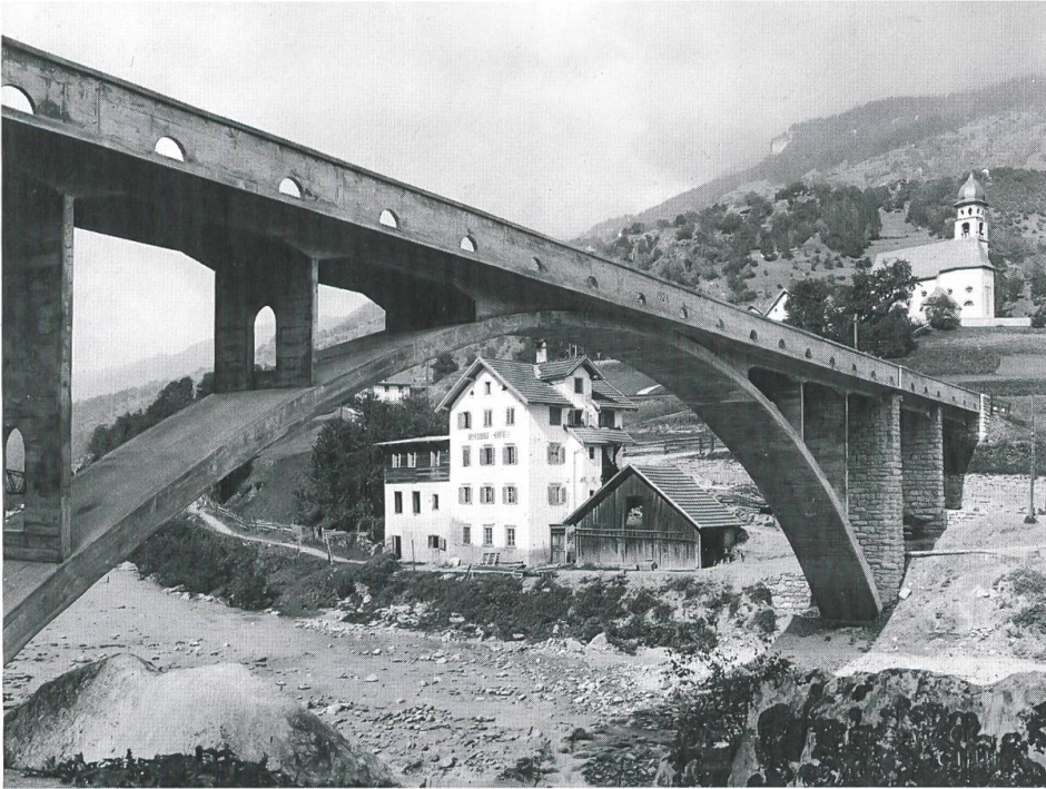
Die vom Churer Ingenieur Walter Versell (1891–1989) entworfene, 1928 für den Automobilverkehr eröffnete Vorderrheinbrücke Tavanasa–Danis. Ihr Abbruch stand bereits fest, weil der Kanton für das Bauwerk keine Verwendung mehr fand. Dank des Engagements des privaten Vereins Nossa Punt konnte das Bau- denkmal gerettet werden. Nach Jahrzehnten vernachlässigten Unterhalts wird es nun fachgerecht restauriert und danach als Brücke für den Langsamverkehr weiterbestehen (Historische Aufnahme/ Verein Nossa Punt).
