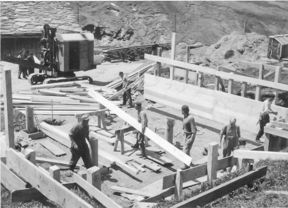
Unsere Wohnbaracke im Bau.
