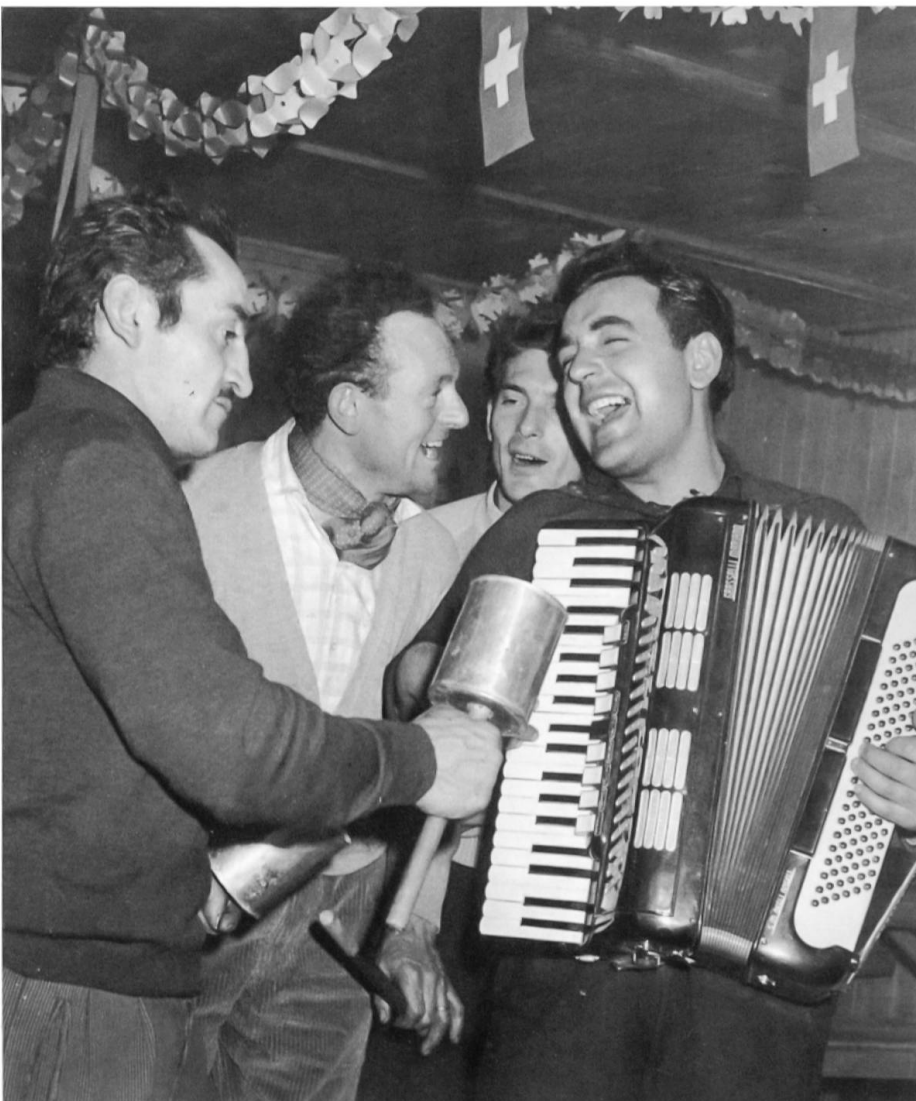
Nach dem Durchschlag: Ausgelassenes Feiern in der Kantine.
