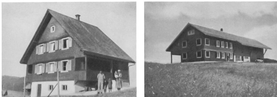
Umsiedlungsprogramm für den Sihlsee, Neubauten nach Plänen der SVIL, Anfang 1930er-Jahre, Aufnahmen kurz nach Fertigstellung (Bernhard 1936, S. 32).
