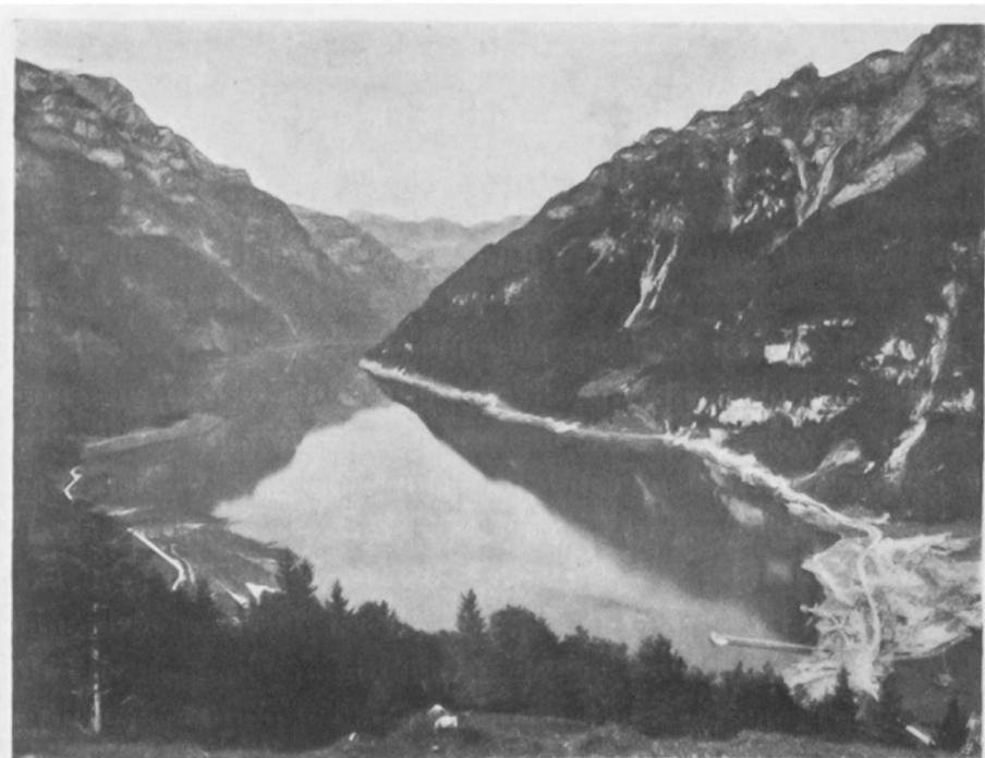
Abb. 16. Der Klöntalersee, wie er ist (gestaut). Seeufer entschieden malerischer geworden. Schutthalde rechts aus der Bauperiode. Cliché der Schweiz. Bauzeitung, Zürich. – Fig. 16. Le lac du Klöntal, aujourd'hui. Les rives sont certainement plus pittoresques. L'éboulis à droite date de l'époque de la construction
