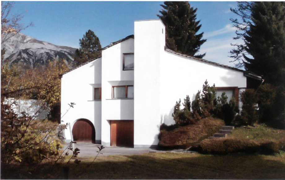
Diverse Umbauten haben den Charakter und die Proportionen des Hauses Zellweger stark verändert. Aus dem niedrigen, sich in den natürlichen Geländeverlauf einfügenden Gebäuden ist auf der Westseite ein dreistöckiges Volumen geworden (Foto: Carmelia Maissen).
