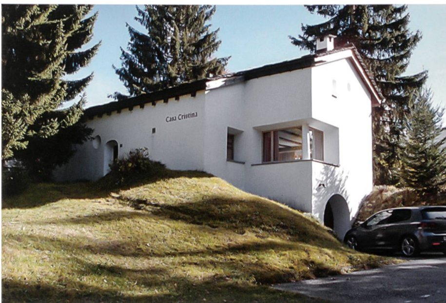
Das Haus Matta besetzt die kleine Anhöhe vor dem Hügel von Las Caglias. Die tiefen Fensterleibungen sind ein Ergebnis der nachträglich angebrachten Aussenisolation (Foto: Carmelia Maissen).
