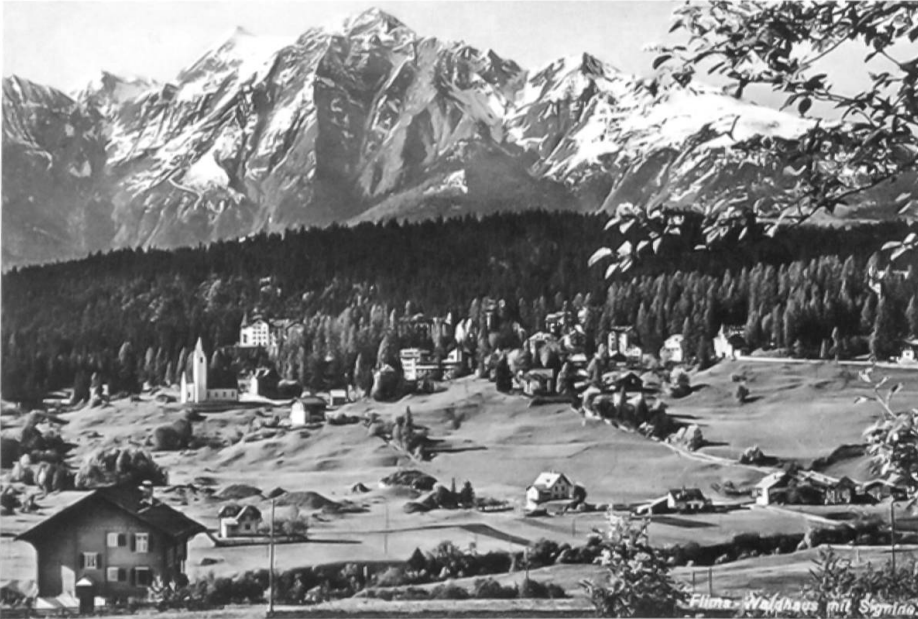
Blick auf Flims-Waldhaus und das noch kaum bebaute Unterwaldhaus (Schuoler 2011, S. 123).
