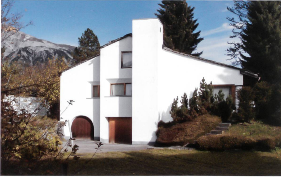
Diverse Umbauten haben den Charakter und die Proportionen des Hauses Zellweger stark verändert. Aus dem niedrigen, sich in den natürlichen Geländeverlauf einfügenden Gebäuden ist auf der Westseite ein dreistöckiges Volumen geworden (Foto: Carmelia Maissen).
