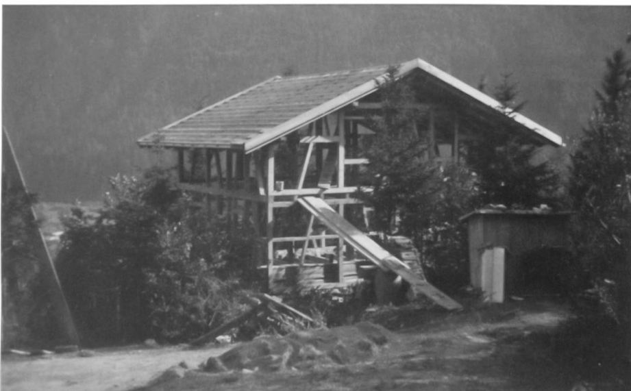
Der Rohbau des Pfadfinderhäuschens im Tersier (Blum).
