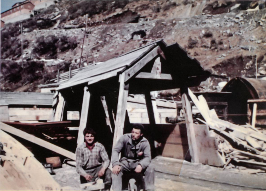
Auf der Baustelle Albigna. Oben links sind die Arbeiterbaracken zu sehen (Bild: Ugo Rossi).
