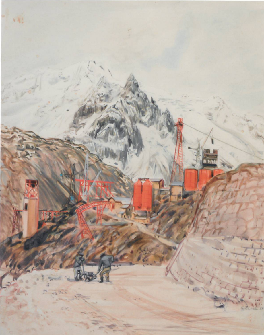
Georg Peter Luck, «Installationen auf dem Bauplatz Albigna», 13. Juni 1957 (Bild 11 in «Wilde Wasser, starke Mauern». – Original: Fundaziun Capauliana, Chur).
