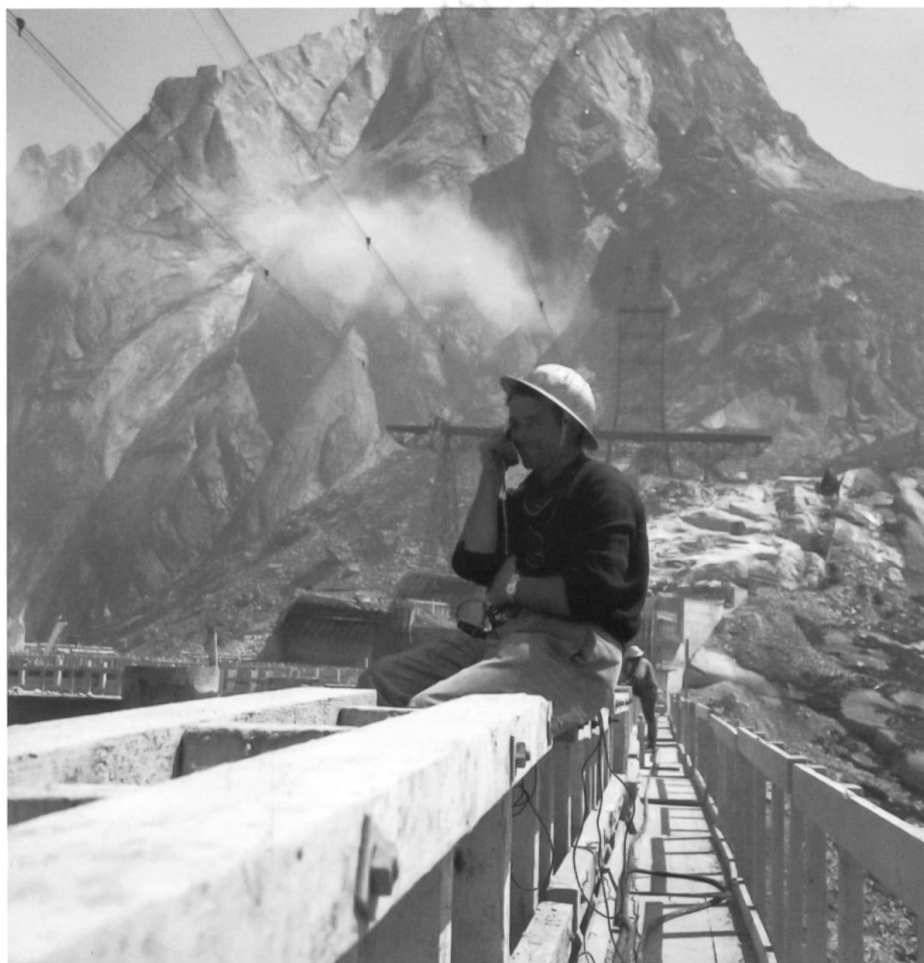
Telefonist auf der Staumauer Er ist mit den drei Kran- führern verbunden und diri- giert die Betonbehälter an den richtigen Platz (Foto: Urs Beyeler, Bern).
