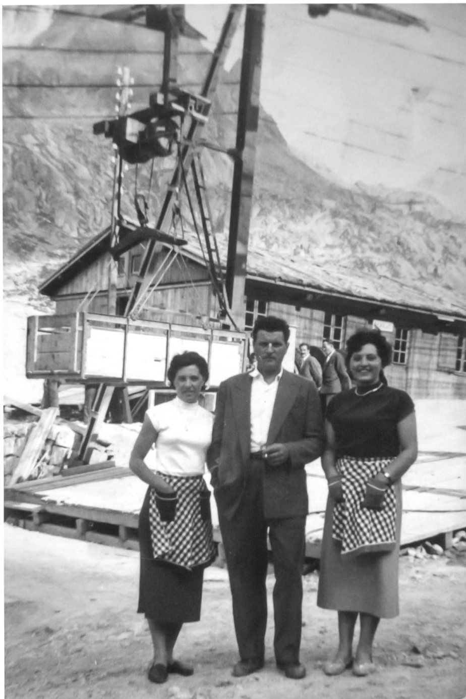
Zwei Angestellte der Kantine und ein Besucher auf der Baustelle Albigna (Bild: Ugo Rossi).
