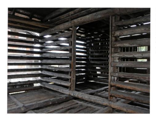
Die Struktur der Scheune mit dem breiten, einst auch als Dreschboden genutzten Mittelgang, an den sich beidseitig verschiedene Kompartimente zur Trennung von Heu und Stroh aufreihen, wurde zum Ausgangspunkt des Umbauentwurfs (Foto: Sara Bonderer, Haldenstein).
