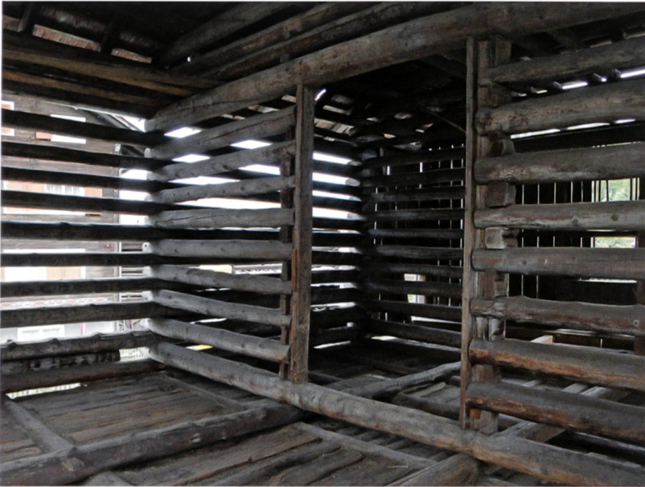
Die Struktur der Scheune mit dem breiten, einst auch als Dreschboden genutzten Mittelgang, an den sich beidseitig verschiedene Kompartimente zur Trennung von Heu und Stroh aufreihen, wurde zum Ausgangspunkt des Umbauentwurfs (Foto: Sara Bonderer, Haldenstein).
