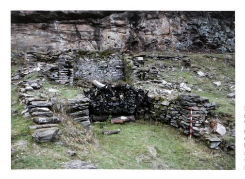
Scatta, Beispiel eines zweiräumigen Wohnbaus. Im Vordergrund das dreiseitig gemauerte Vorderhaus. Der darüber gesetzte Blockbau hat sich nicht erhalten. Rückseitig gegen den Fels, das vollständig gemauerte Hinterhaus (Foto Y. Alther).
