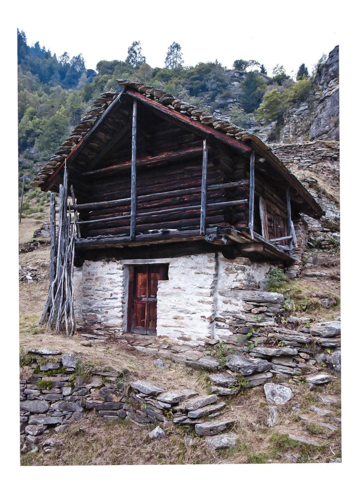
an der Westwand aus dem 18. Jahrhundert und an der Wandpfette der Ostwand keine Veränderungen am Blockbau auf. Diese Stallscheune datiert ins Endjahr 1520.
