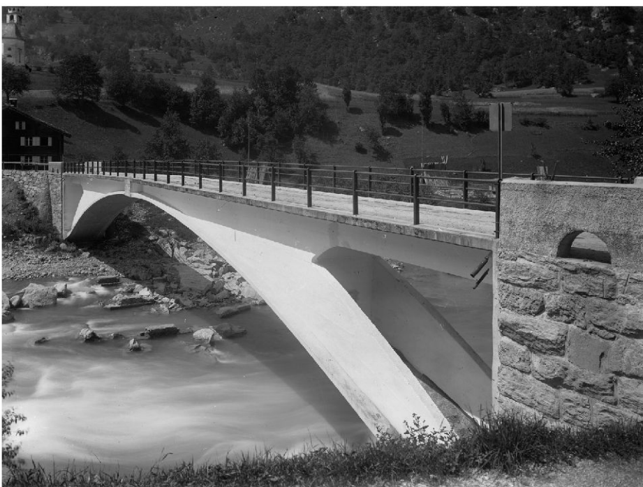
Maillarts Vorderrheinbrücke Tavanasa, die erste Dreigelenk-Hohlkastenbrücke mit ausgeschnittenen Bogenzwickeln (1905–1927) (Foto: Carl Lang/Capauliana/Fotostiftung Graubünden).
