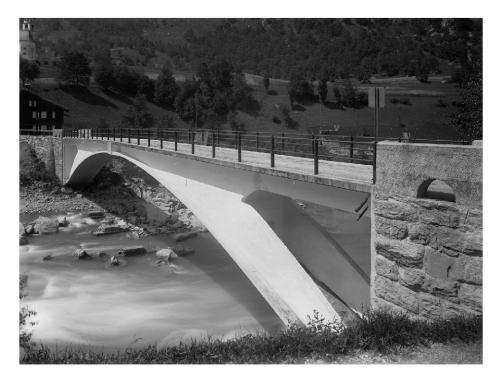
Maillarts Vorderrheinbrücke Tavanasa, die erste Dreigelenk-Hohlkastenbrücke mit ausgeschnittenen Bogenzwickeln (1905–1927) (Foto: Carl Lang/Capauliana/Fotostiftung Graubünden).
