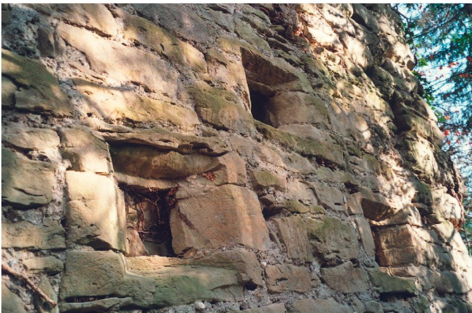
Arconciel, Westturm (Freiburg). Kleinfenstergruppe im Südteil der Westfassade, drittes Geschoss (Foto: Lukas Högl, Zürich).
