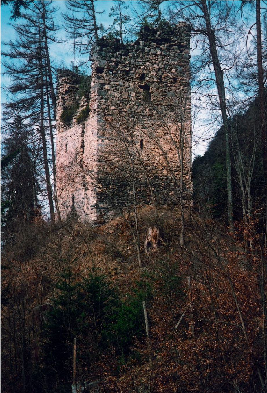
Klingenhorn. Ansicht von Südosten. Der Sockel des ehemaligen Obergadenturms ist am stärker deckenden Verputz zu erkennen (Foto: Lukas Högl, Zürich).
