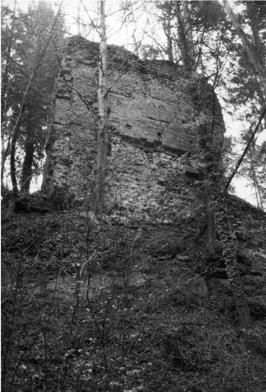
Arconciel, Westturm (Freiburg). Ansicht von Westen (Foto: Lukas Högl, Zürich).
