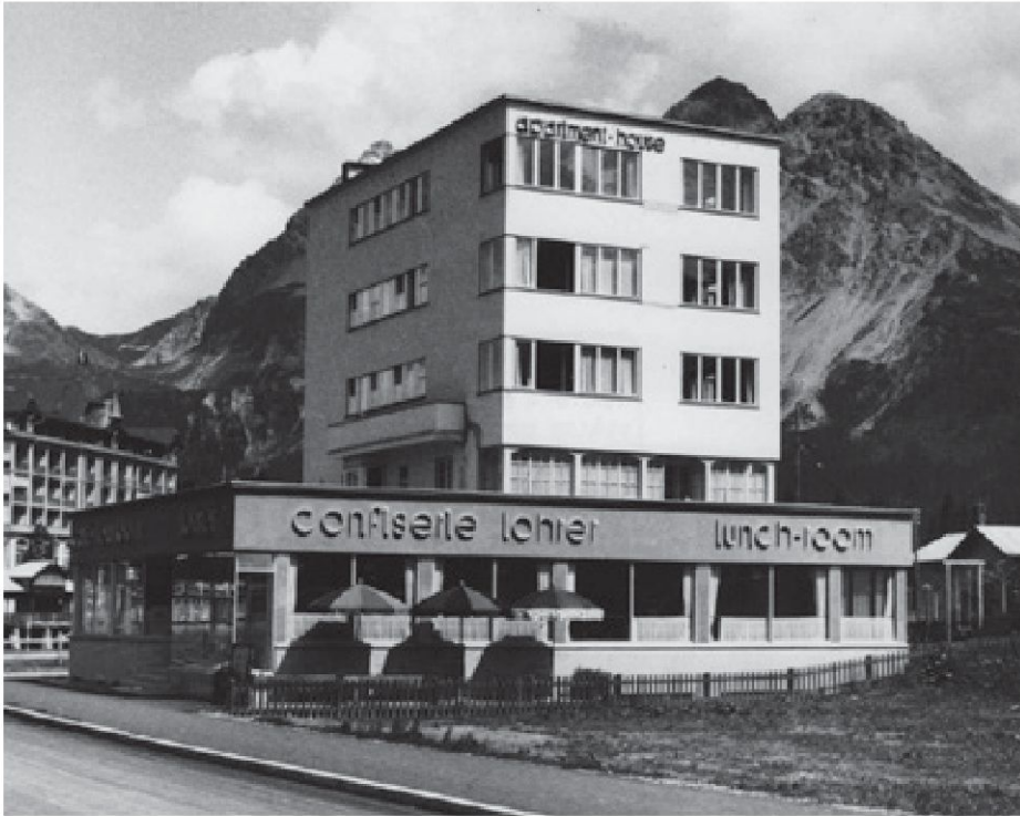
Hotel Carmenna, vormals apartment-house und confiserie lohrer, 1931 (Arch.: Jakob Licht).
