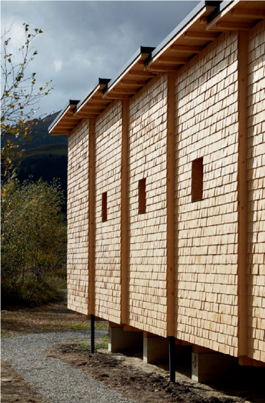
Ein Schindelschirm überzieht die Längsfronten.
