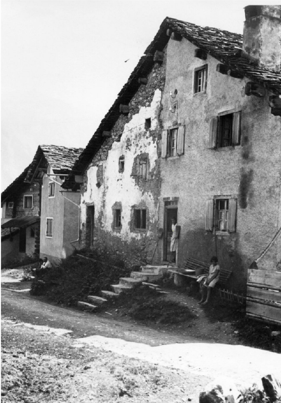
Strassenfassade des Hauses Loringett um 1933, vor der Renovation des Gebäudes (Sozialarchiv Zürich).
